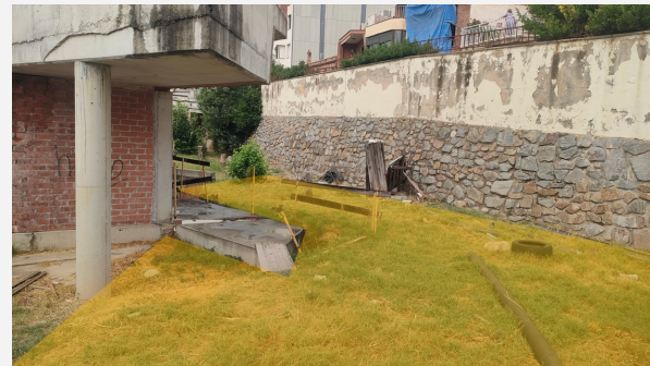
TRÀNSIT MAQUINÀRIA DE DEMOLICIÓ
