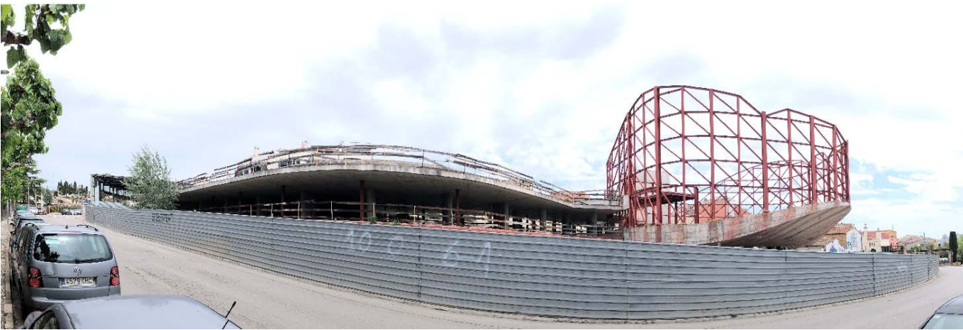
Fig. Vista exterior de l'estructura i tanca d'obra actuals des del Passeig de les Oliveres
