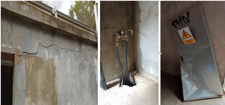
Figura 4. Caseta de connexió i equips
