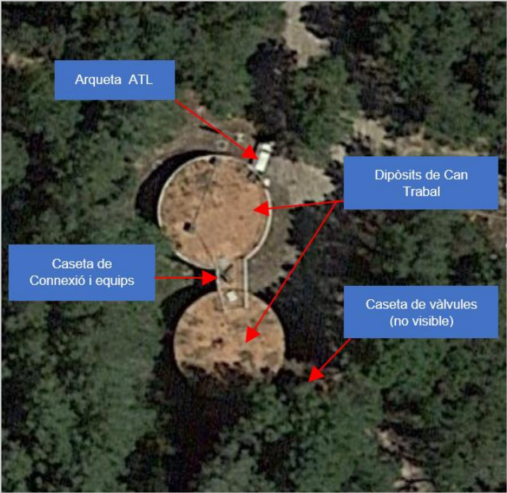
Figura 2. Dipòsits de Can Trabal
