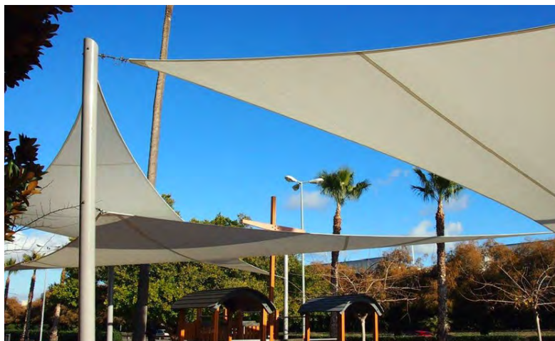
Zones d'ombreig amb màstils d'acer galvanitzat i veles tensoestàtiques
