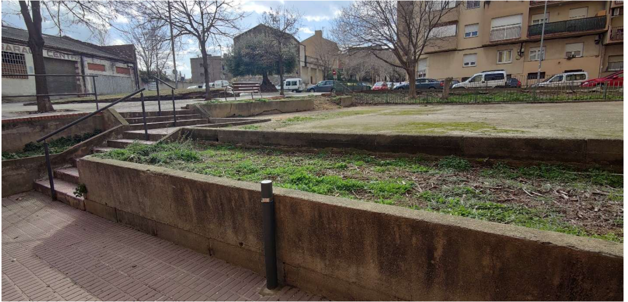
Imatge de la zona dels antics dipòsits amb un salt de cota de 1,5 metres que dificulta l'accessibilitat i el transit de vianants.
