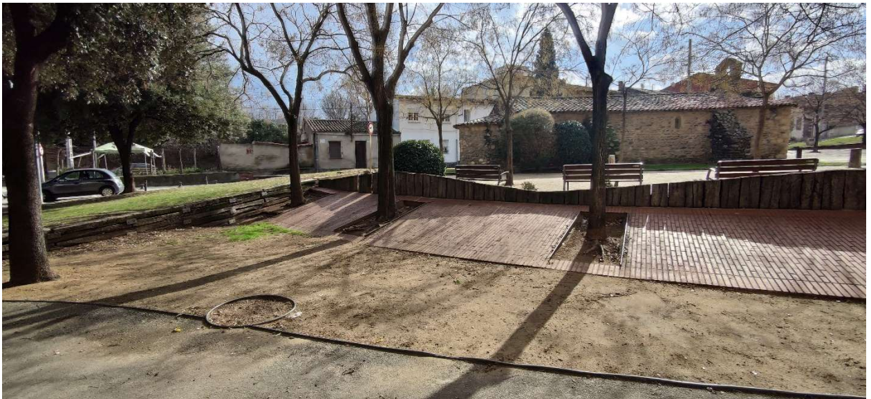
Imatge de la franja de paviment i la tanca de fusta que delimita la cota superior de la plaça amb la cota inferior.
