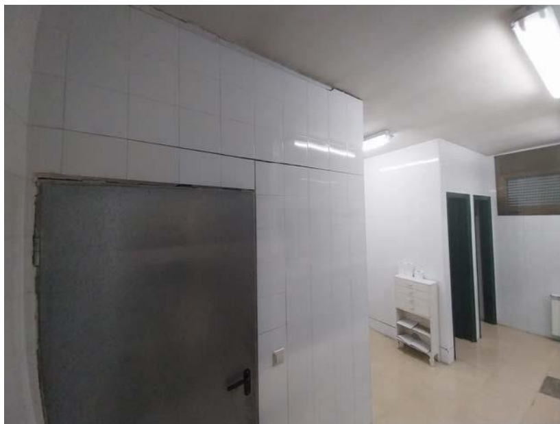
Fig.7: Espai bany de l'operatiu del Parc de Bombers de Puigcerdà
