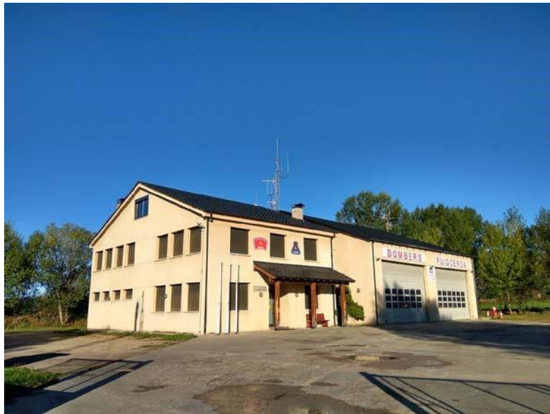
Fig. 4: Vista de la façana principal del Parc de Bombers de Puigcerdà i l'accés a cotxeres.
