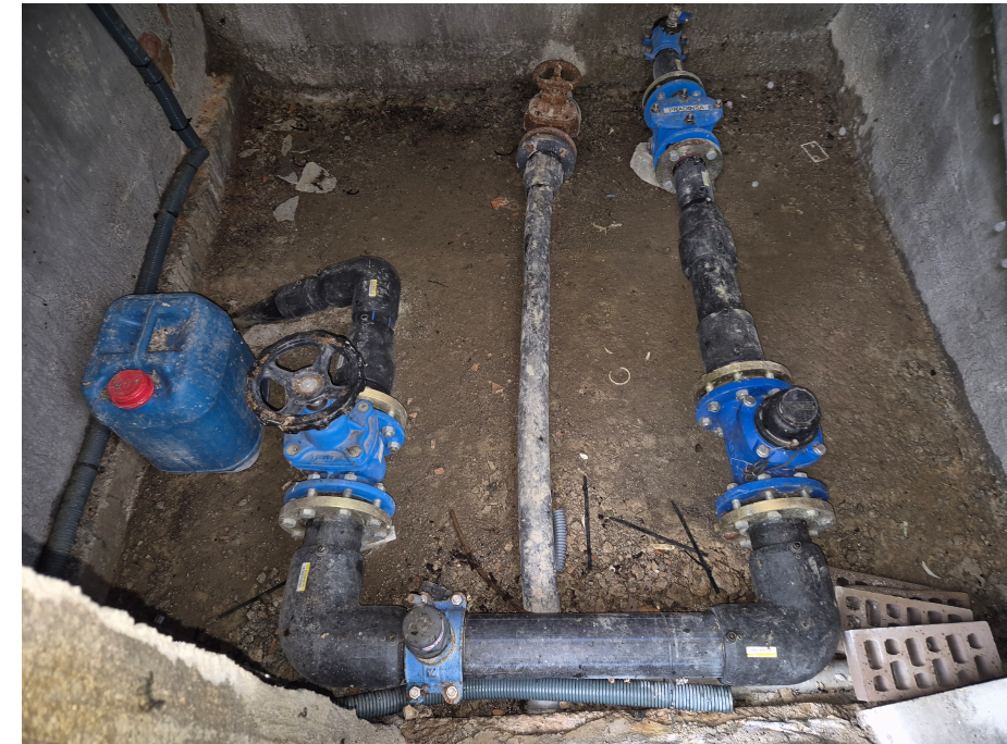
Foto 4 Vista de les canonades de sortida al poble i de desguàs de fons del dipòsit. Cal destacar la posició errònia de la ventosa aigües amunt de la clau de tall, quan hauria d'anar muntada aigües avall de la clau de tall.
