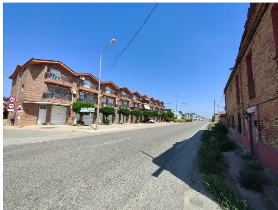
FOTO 1.- Inici zona actuació carretera C-13
