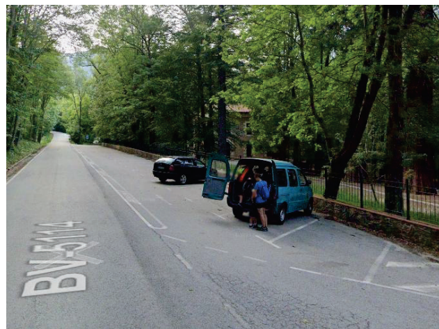
Figura 3. Estat actual de l'aparcament de Can Casades
