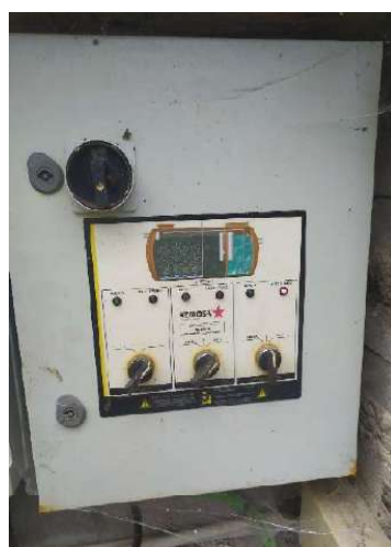
Foto 6: Detall quadre elèctric i de comandament EDAR actual.
