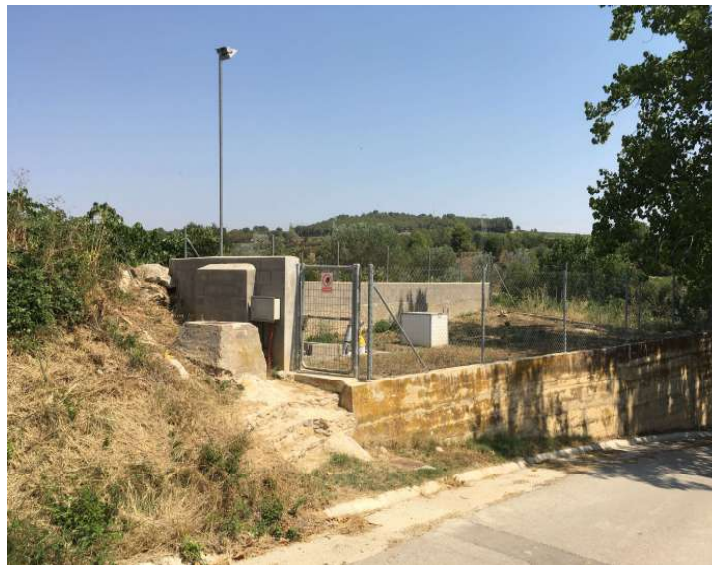
Foto 1.- EDAR, estat actual.
