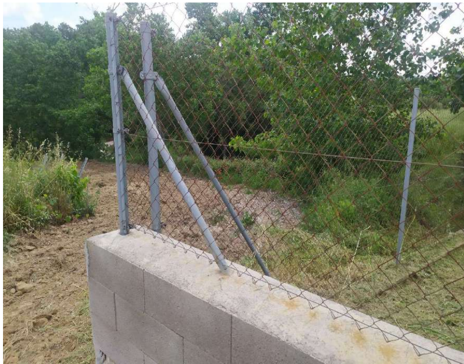
Foto 8: Emplaçament prolongació EDAR nova línia.
