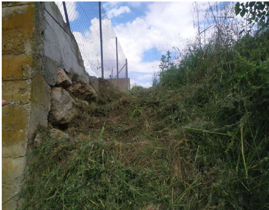
Foto 4: Límit EDAR actual on es prolongarà la nova línia.
