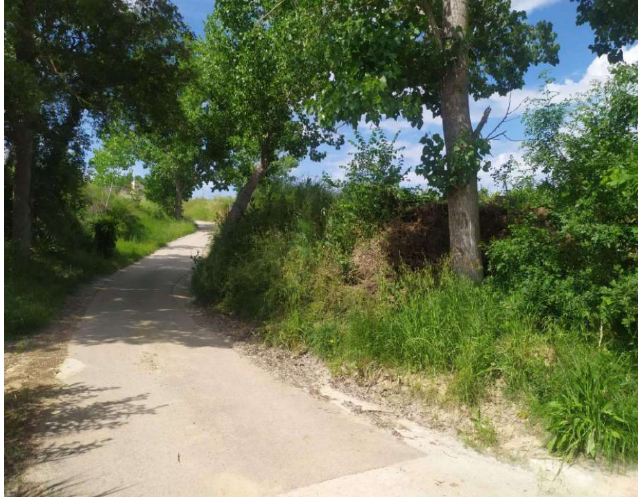
Foto 11: Camí que va de la EDAR al Torrent on aboca vista des del Torrent
