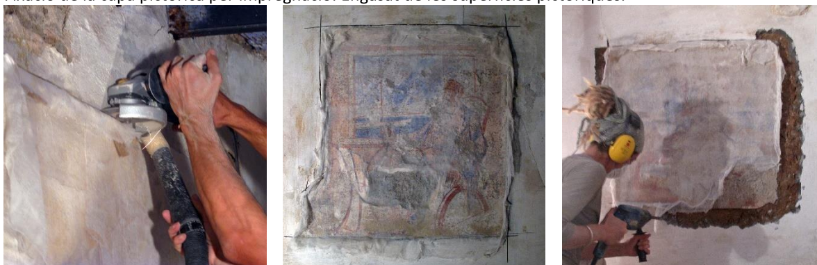
Obertura de rases perimetrals a l'entorn de les pintures, després de l'engosat i abans de l'arrencament.
