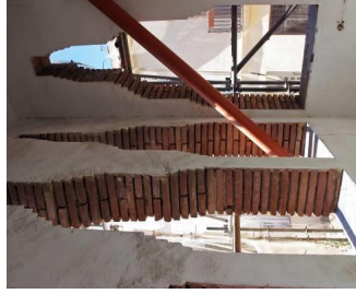
Vista general Galeria P1.
