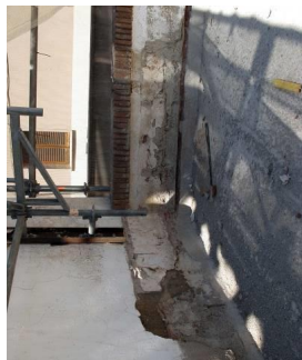
CR.03. Jardinera desmuntgada i el seu emplaçament original (Terrassa P1).
