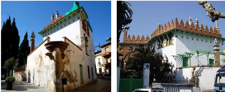
Vistes generals de l'exterior; Façana del Carrer Dolors Monserdà i Plaça del Vendre.
