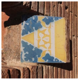
CR.01. Cornisa ceràmica (Coberta). Rajoles R.01, R. 14 i R.40.
