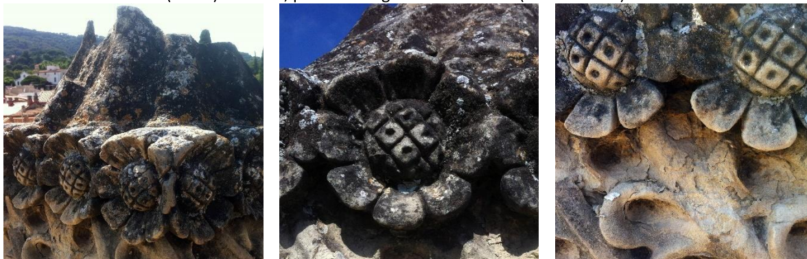
Recobriments biogènics i degradació de la Pedra de Vilaseca en forma de disgregació i exfoliació (EP.01).
