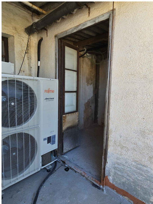
Terrassa 2 Cal arrenjaments de façana, canal, baixant, pavimentació i obertures
