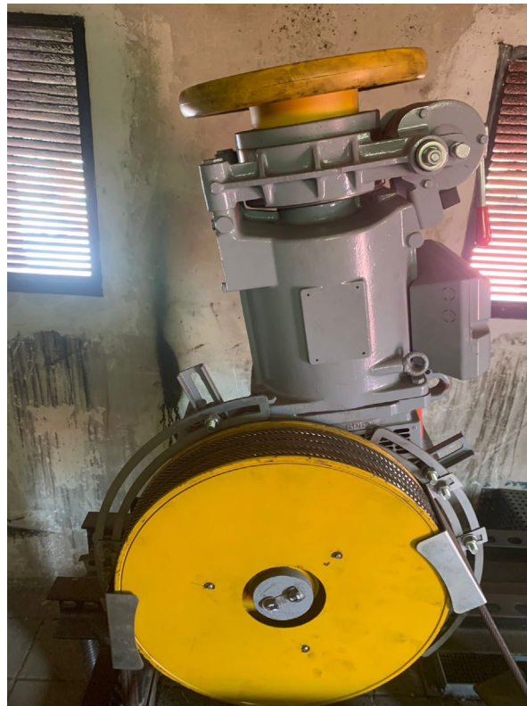
Detall del grup tractor amb reductor
