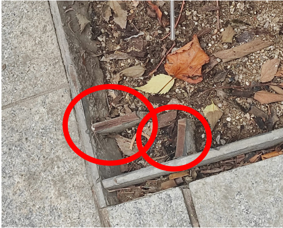
Imatges de detall de les plelines dels limitadors ja retirats en les cantonades dels parterres.
