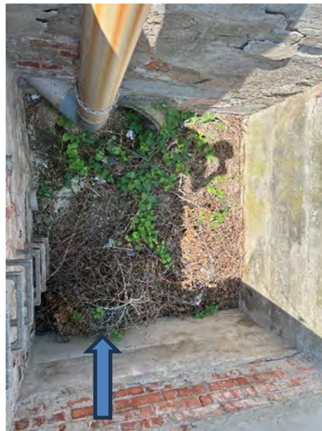
Arqueta de control 2 de recollida d'aigües pluvials i punt de sortida de les aigües pluvials (canonada a canviar)
