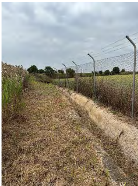
Cuneta perimetral extrem nord-oest
