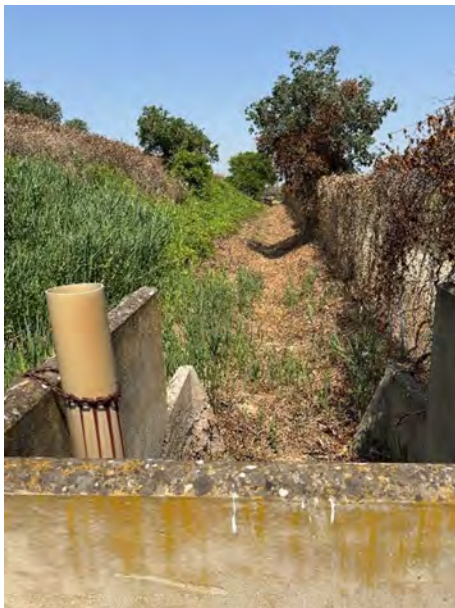
Arqueta de control 2 de recollida d'aigües pluvials i punt de sortida de les aigües pluvials (canonada a canviar)
