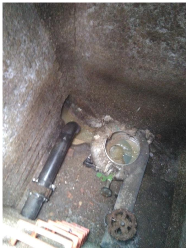
Fig. 6.2: Cambra seca típica d'un vòrtex
