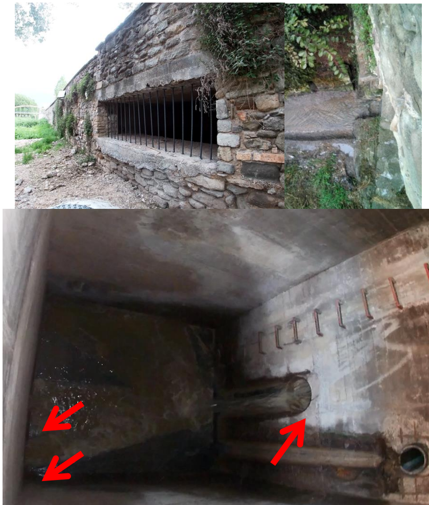
Fig. 3.9. a) Alleujament de A_001. b) enreixat VX_001 c) VX_001. S'observen 3 tubs influents (+ 1 sec) i la sortida, per l'extrem superior esquerre de la foto.
