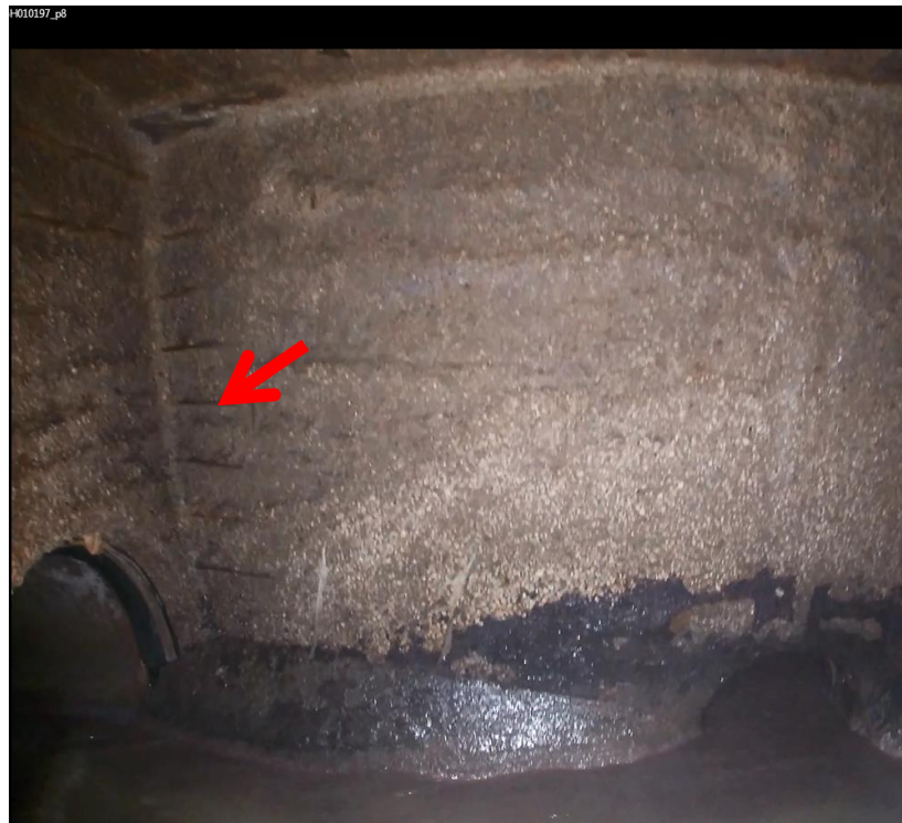
Fig. 3.11 Pou A_016. Marques horitzontals a la cantonada esquerra. Pot tractar-se de l'acer de l'armat. A la cantonada inferior dreta, escomesa del col·lector sud, de santa Eugènia de Berga
