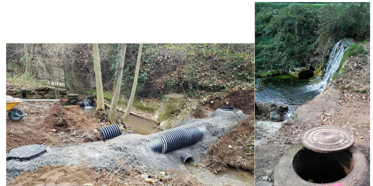
Fig. 3.3: a) Nou tram d'uns 60 m de longitud. Any 2018. b) Notable interès paisatgístic del tram
