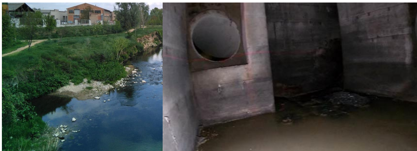
Fig. 3.13. a) Sortida sobreeixidor VX_006; b) Interior VX_006.
