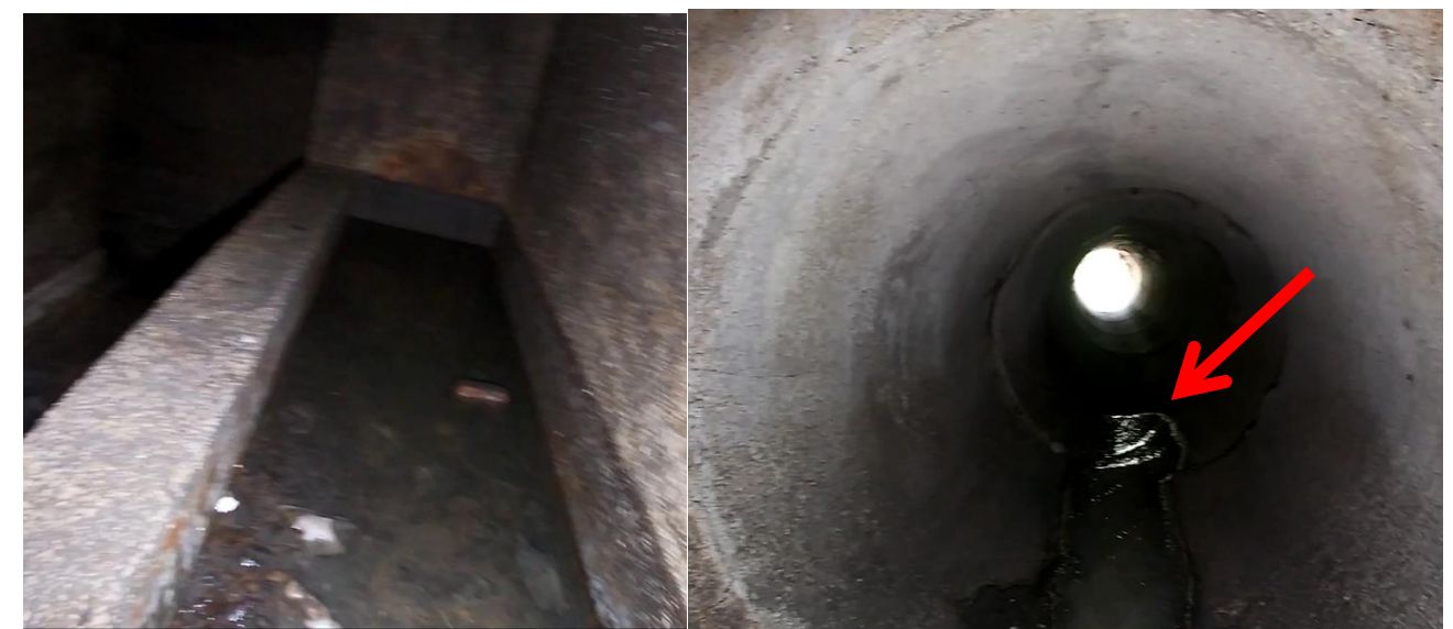
Fig. 3.14 a) VX_007. Sortida sobreeixidor anul·lada; b) escomesa en baixa al A_027, des de el fons del tub, el que provoca un sobreeiximent immediat de la xarxa en baixa.
