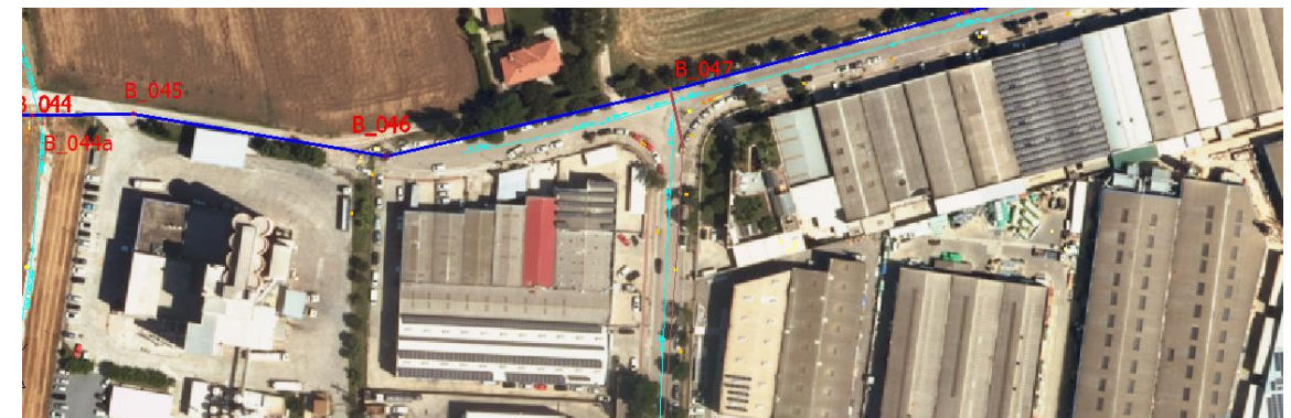
Fig. 7.19 Carrer Tarragona. B_047. El col·lector rep directament la connexió sense possibilitat d'alleujat. Qualsevol introducció de pluvials paràsites a la xarxa de residuals col·lapsa ràpidament el col·lector.
