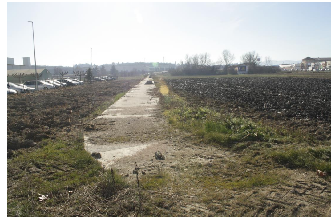
Caixó pluvials junt a B_044
