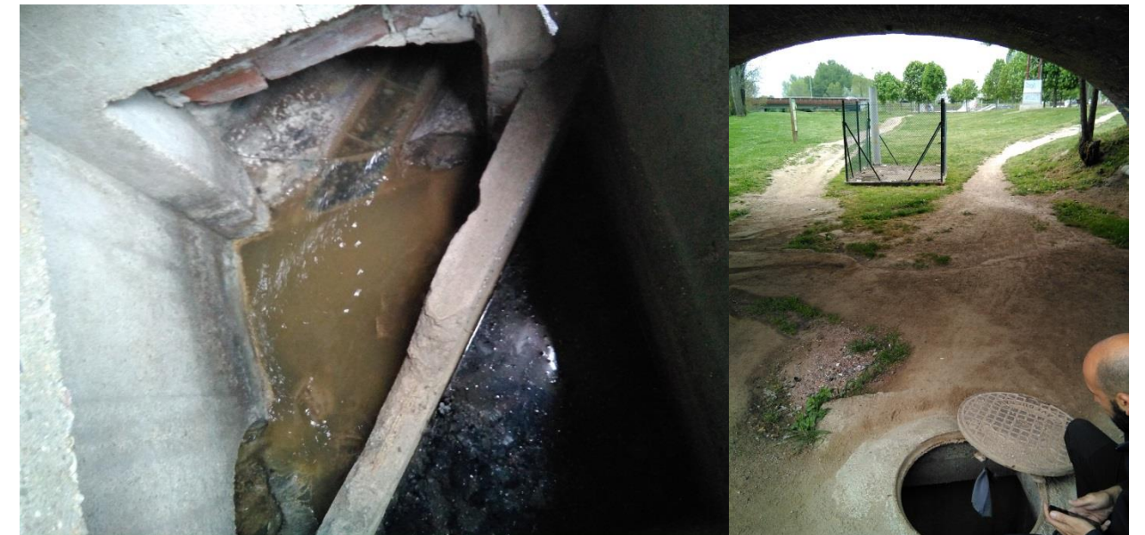
Fig. 8.6: Sobreeixidor VX_005a_S. Considerem l'anul·lació del sobreeixidor.
