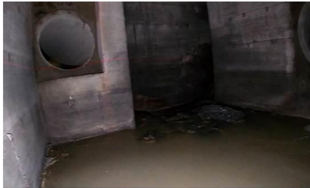
VX_006_S. Mesura cota llavi sobreiximent
