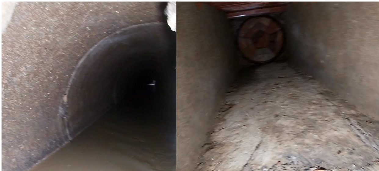
Fig. 3.15. a) Pou A_026_S. Al fons trapa de A_027 oberta; b) Sobreexidor en A_026_S, incloent-hi clapeta sortida.
