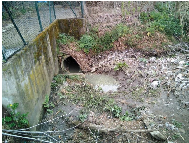
Fig. 6.8. Xàfec 2019.04.02. Sobreeximent Evident de VX_008 (S7). Intensitat màxima en 30 min de 8,2 mm / h. Precipitació total de 19 mm. El desbordament es dona per a la segona pluja (22:00), encara que és de menor intensitat que la pluja a les 18: 00
