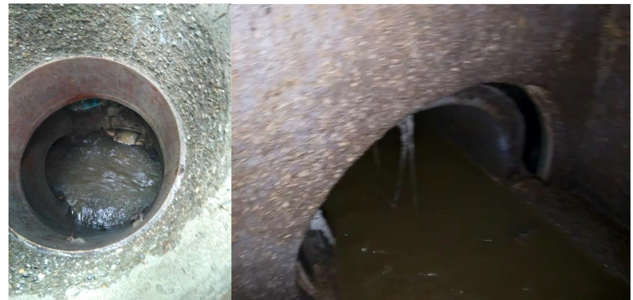
Fig. 3.10a) Tub \phi 800 en A_008. B) Tub \phi 1200 en A_013. Aparentment de formigó.
