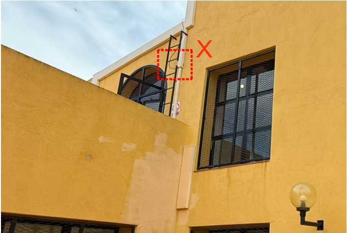
REPARACIÓ TRAM ESCALA DE GAT EXTERIOR
