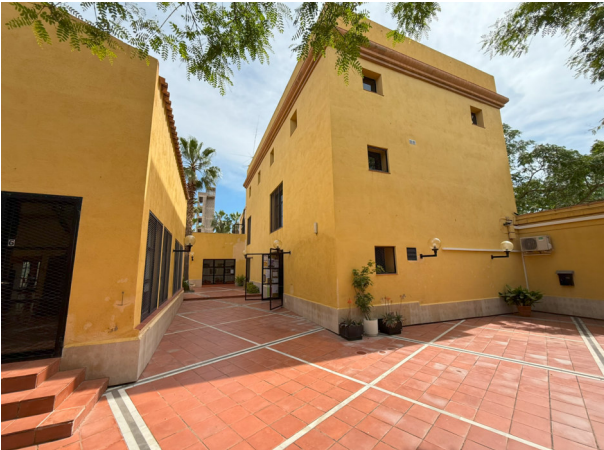
PINTAT FAÇANES PATI INTERIOR
