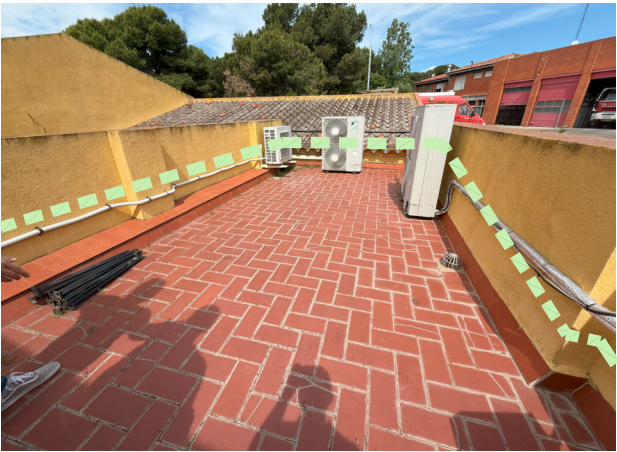
SUBSTITUCIÓ DE COBERTA TRANSITABLE
