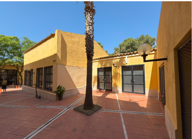
PINTAT FAÇANES PATI INTERIOR
