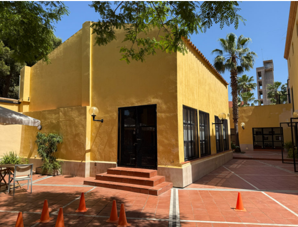
PINTAT FAÇANES PATI INTERIOR
