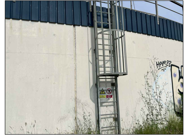
Exterior dipòsit E5-02
