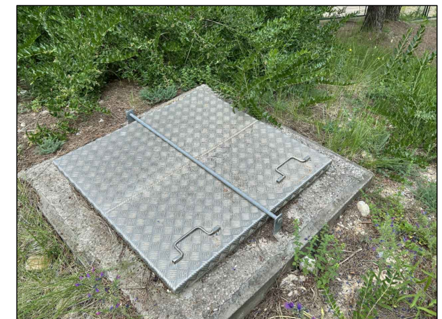
Arqueta Desguàs N° 1
