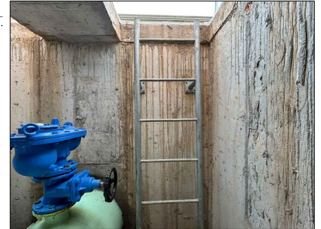
Interior arqueta D6-61
