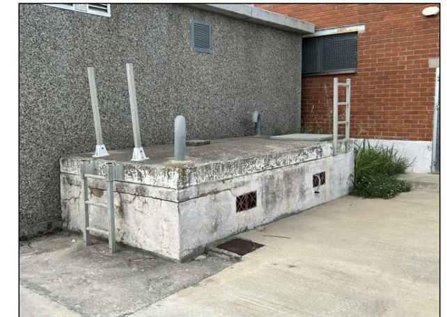
Exterior arqueta F6-38
