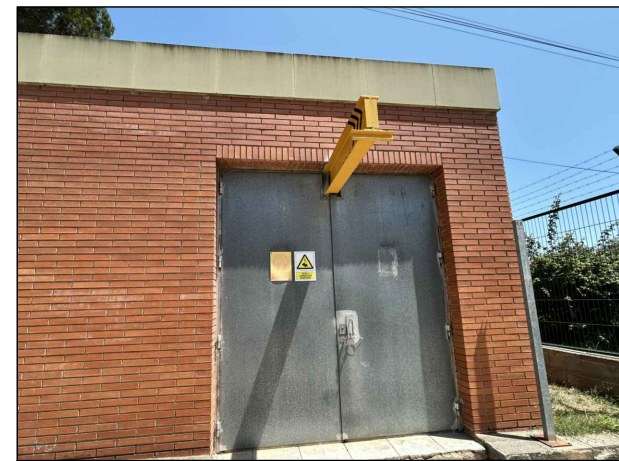
Exterior estació bombament
