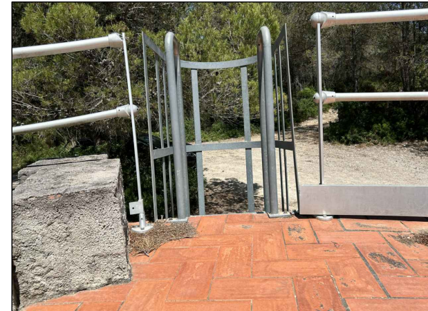
Coberta del dipòsit D2-08
