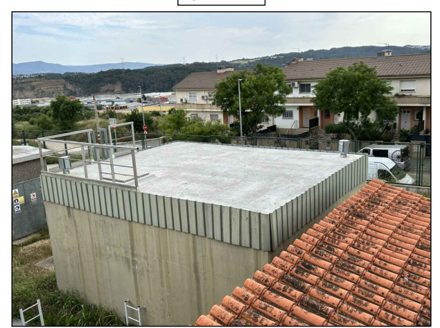
Coberta dipòsit auxiliar
