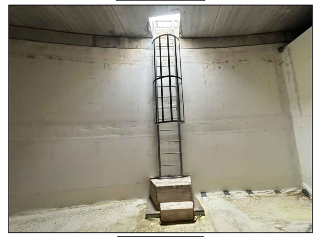
Interior dipòsit E5-02
