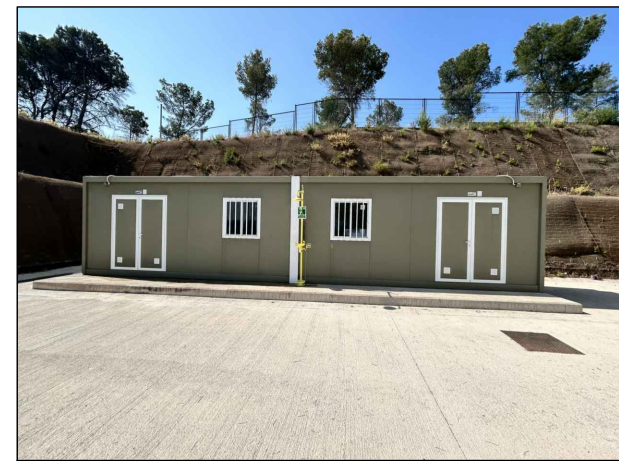
Sales, hipoclorito, electrocloració
