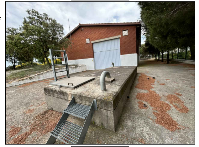
Exterior arqueta E7-31
