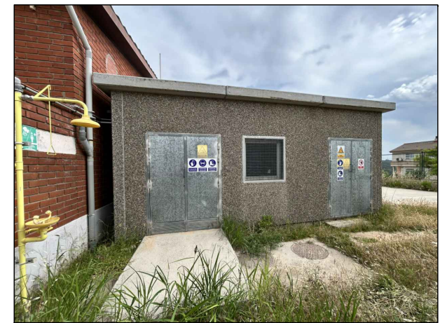
Sala de electrocloració i electrogeneració
