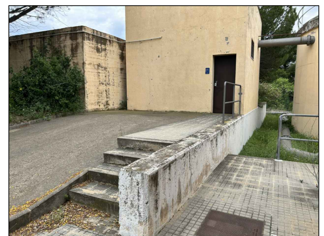
Exterior arqueta E7-33
