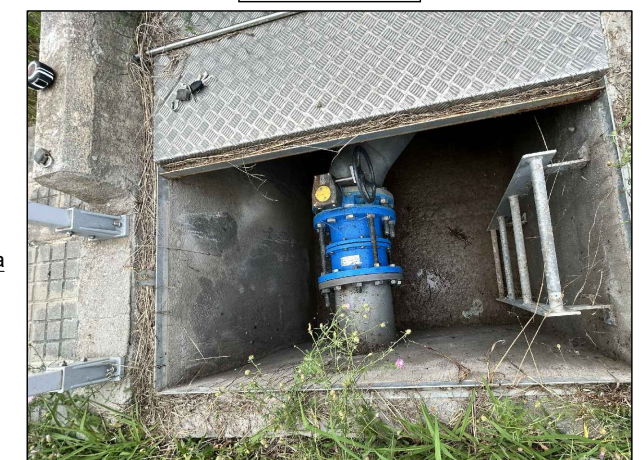
Interior arqueta E7-1D
