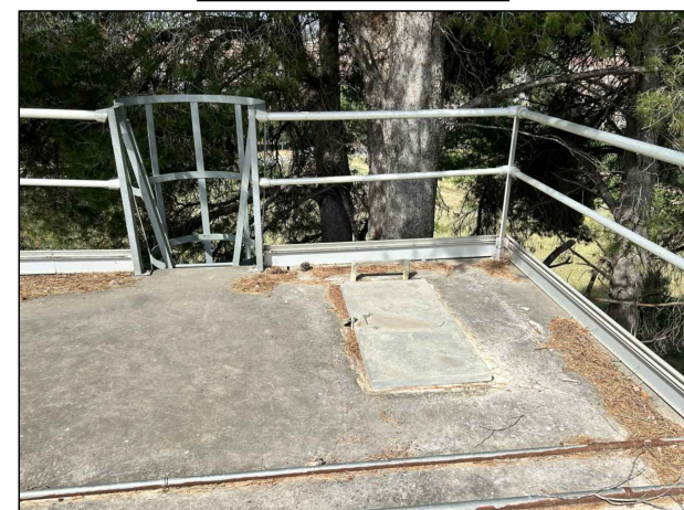
Coberta de dipòsit
