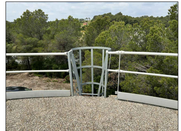
Coberta de dipòsit
