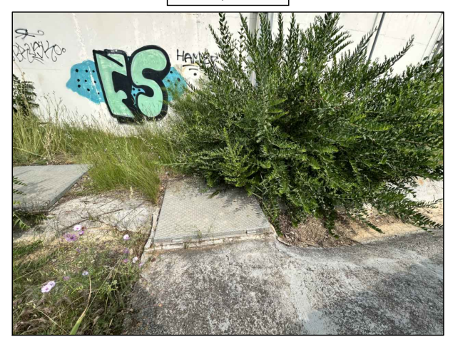
Arqueta exterior nº 1.
