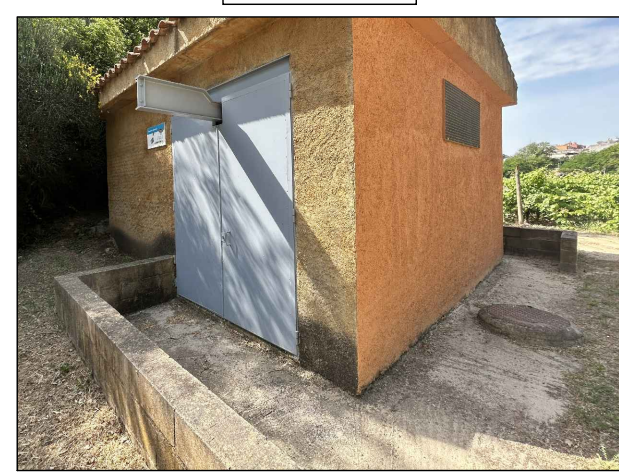
Exterior caseta derivació
