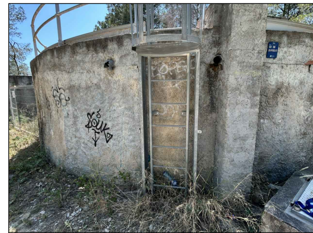
Escala d'accés a coberta del dipòsit D2-08
