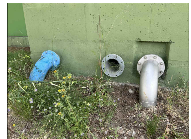
Exterior arqueta de sortida
