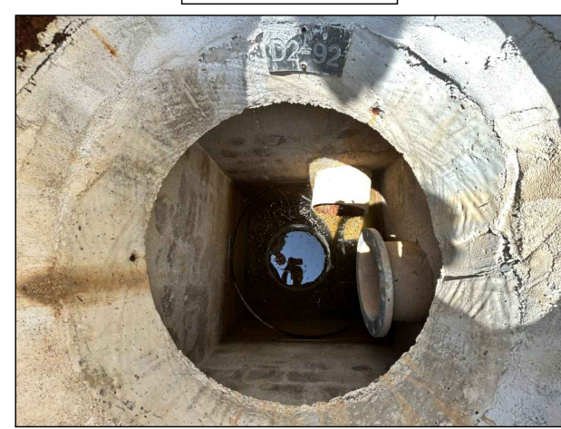
Interior arqueta desguàs D2-92
