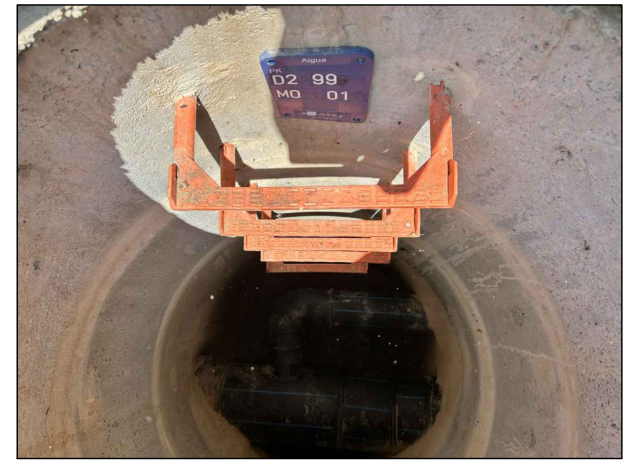
Interior pou desguàs D2-99
