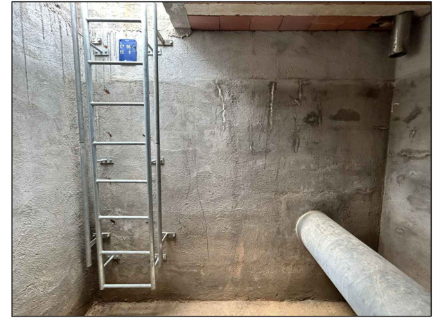
Interior arqueta E7-98
