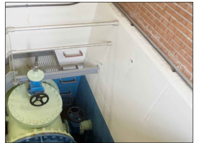
Interior caseta de derivació, retirada de pates
