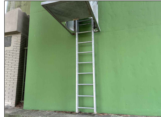
Escala d'accés a coberta del dipòsit
