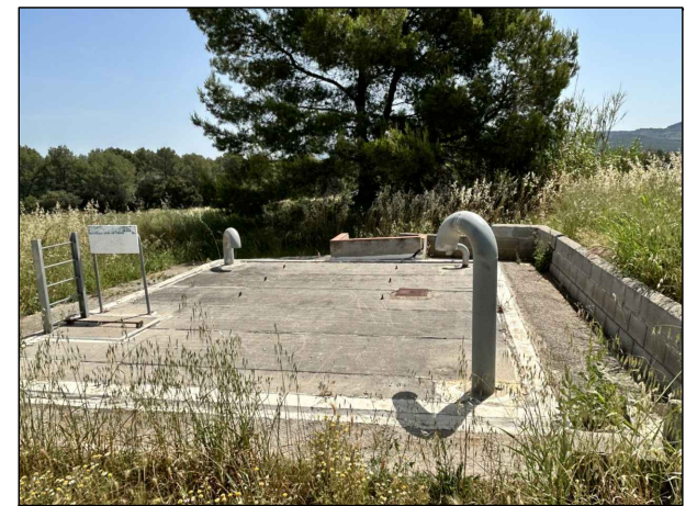
Coberta de la caseta de derivació
