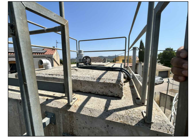
Accés a coberta de l'obturador
