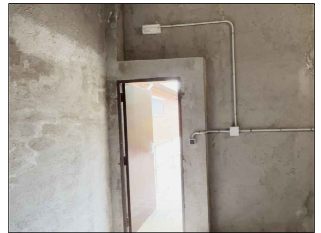
Interior arqueta E7-33
