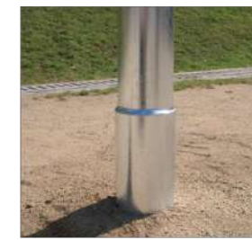
Detalle de la base del mástil reforzada
