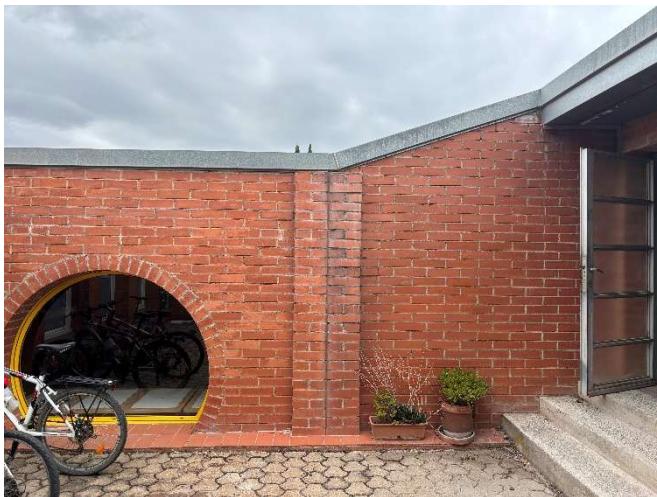
Detall exterior coberta
