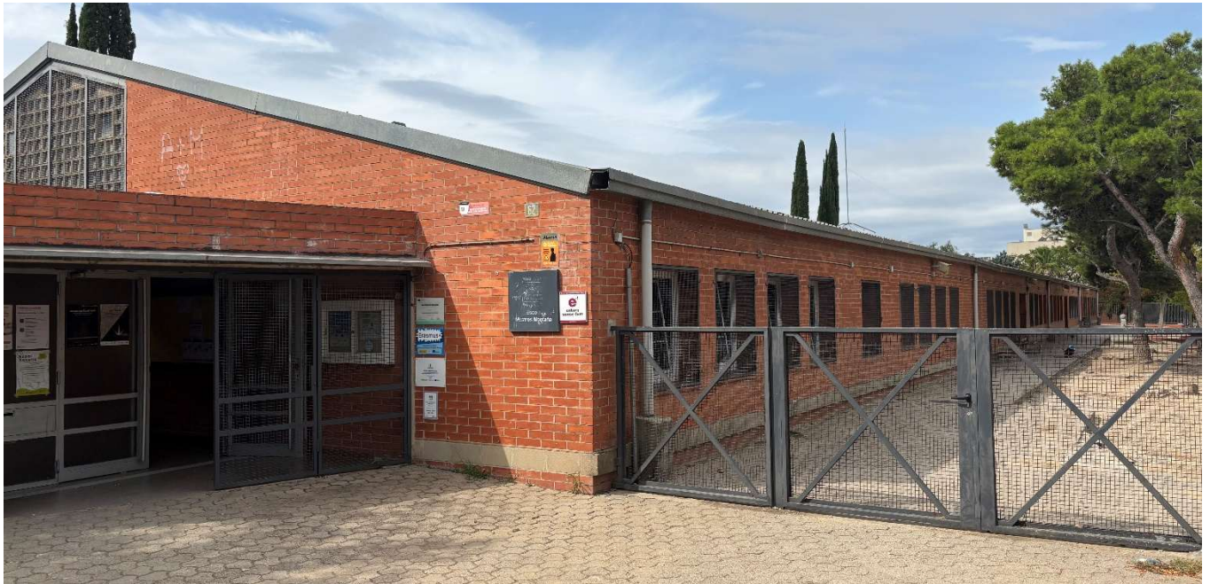
Detall exterior coberta
