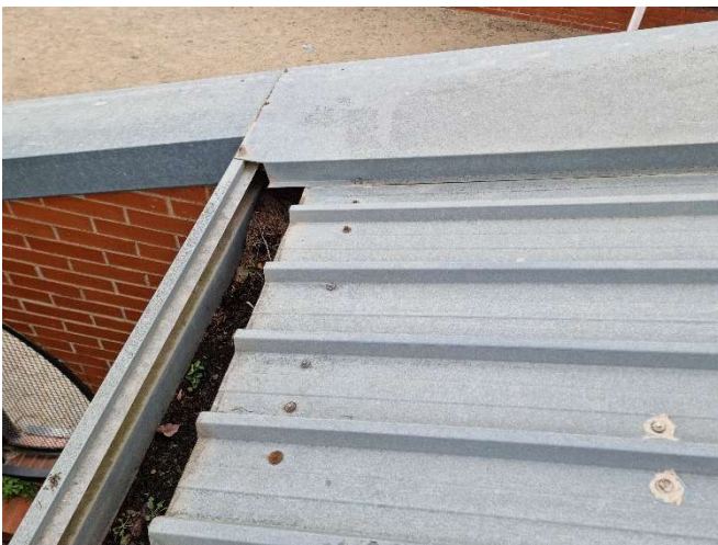
Detall canal coberta
