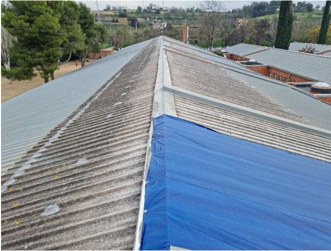
Vista exterior coberta
