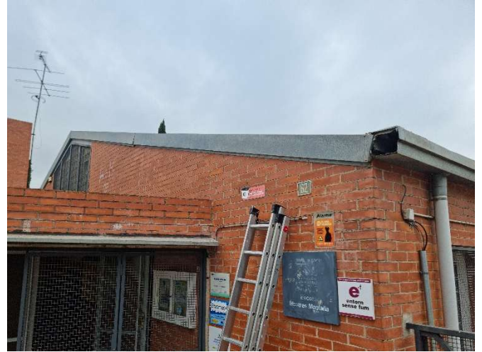
Vista exterior coberta
