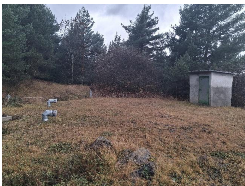
Figura 6. Exterior del dipòsit Nou.
