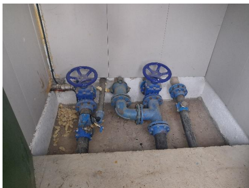
Figura 4. Canonada de sortida del dipòsit Nou.
