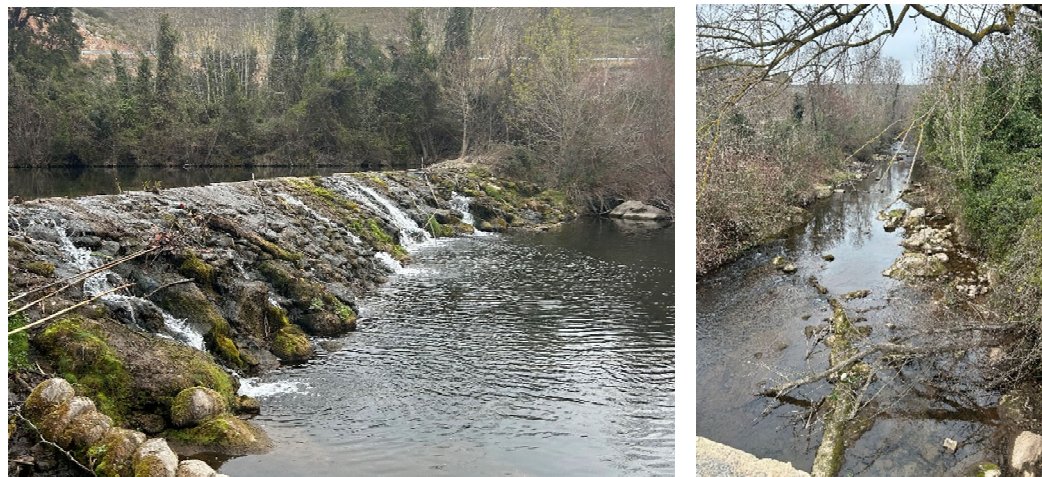
Figura 3. Vista de la resclosa i del canal.
