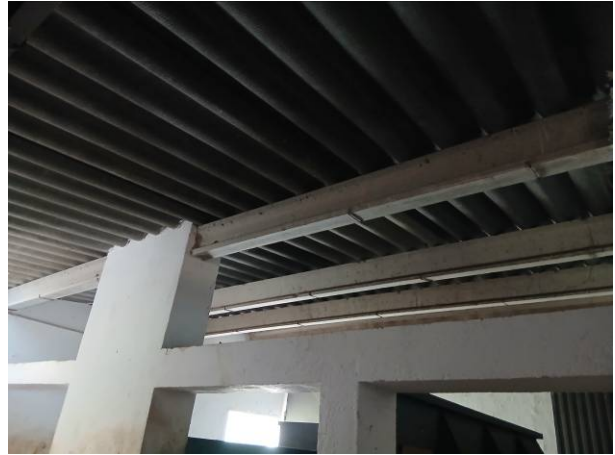
Fotos 1 i 2: Vista façana principal de l'escorxador i detall de la coberta de fibrociment actual..
