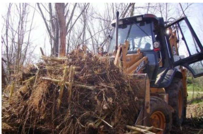
Figura 17 Procés mecànic d'eliminació de canya.
