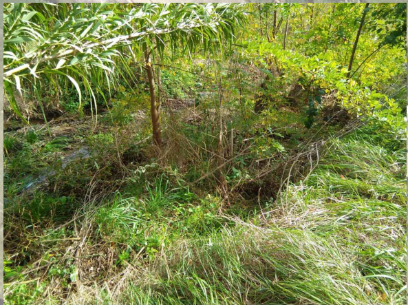
Tram D. Vista des dels talussos
