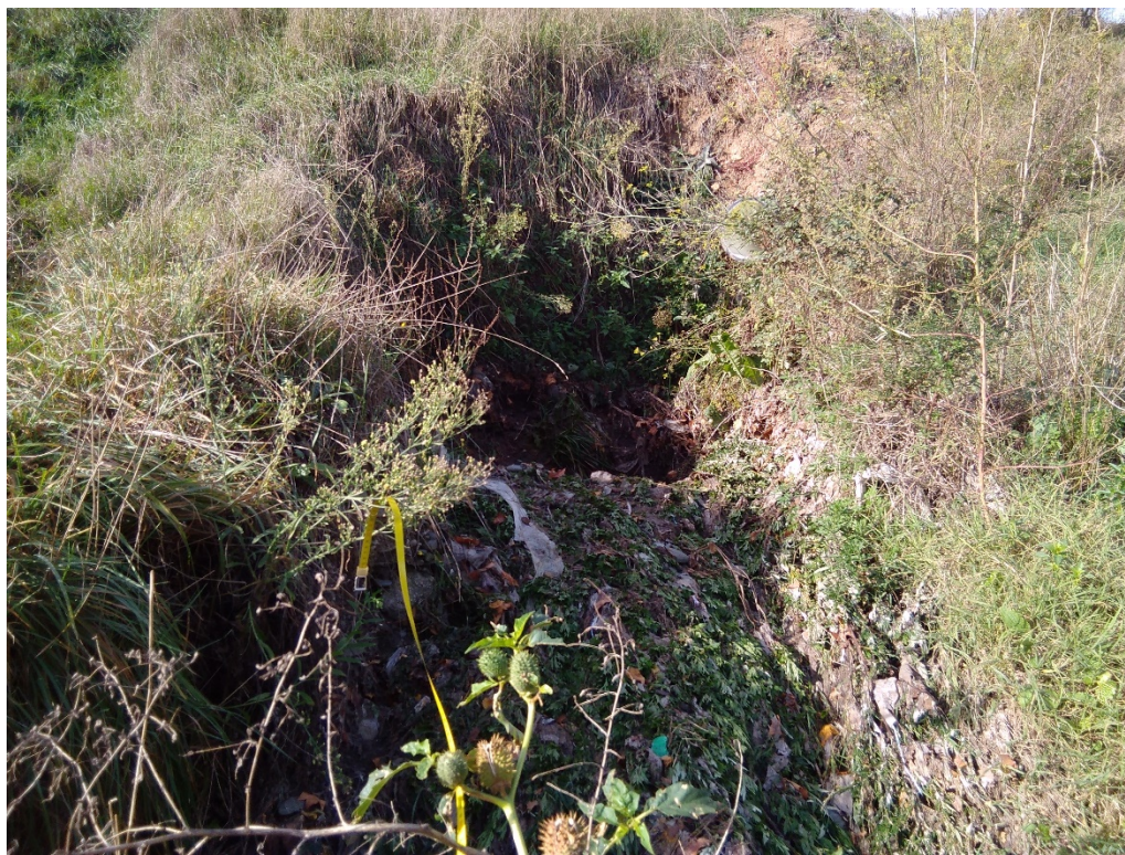
Figura 9 Sortida del sobreeixidor d'aigües residuals. Tram A
