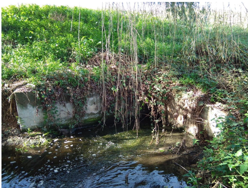
Figura 18 Actual sortida de l'EDAR en el marge dret de la riera. Tram C (vista aigües amunt)
