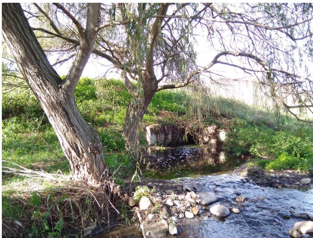
Figura 17 Actual sortida de l'EDAR en el marge dret de la riera. Tram C (vista aigües amunt)
