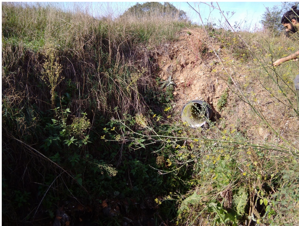
Figura 8 Sortida del sobreeixidor d'aigües residuals. Tram A
