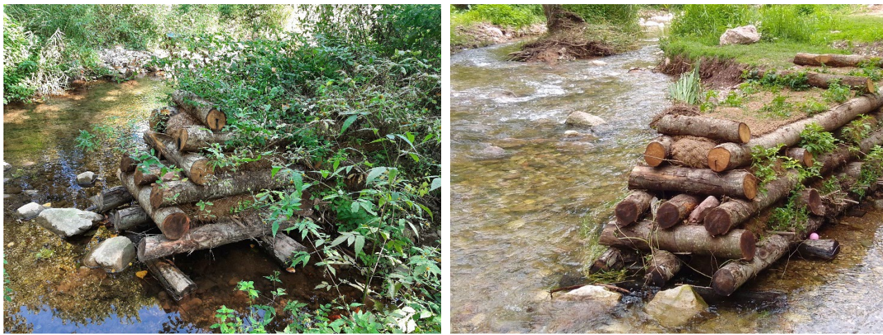
Figura 28 Deflectores amb entramat Krainer executats per Naturalea
