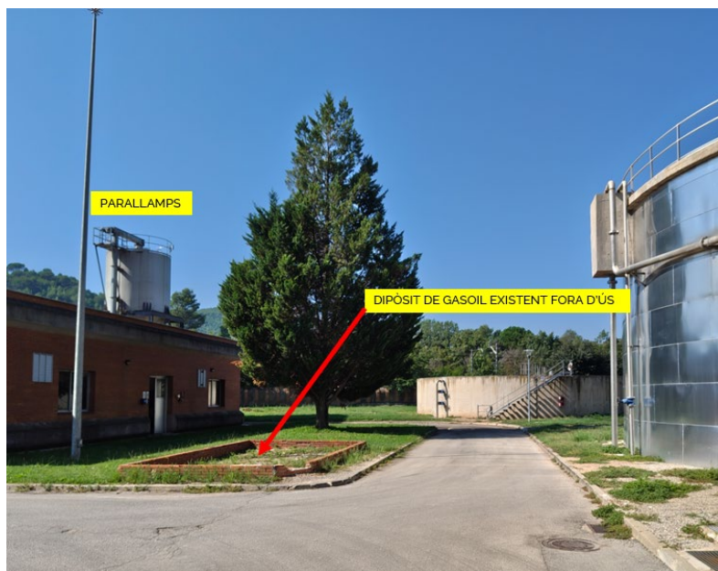
Figura 5: Estat actual de la zona prevista per la nova cogeneració
