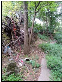
11 vista de la llera en el punt indicat
