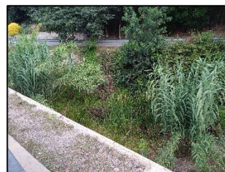
17 vista de la llera en el punt indicat
