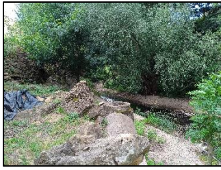
09 vista de la llera en el punt indicat
