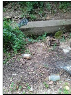
12 estructura de formigó
