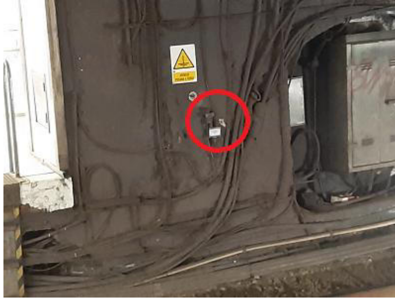
Figura 6 Element passiu a la boca de túnel (Urquinaona L4)
