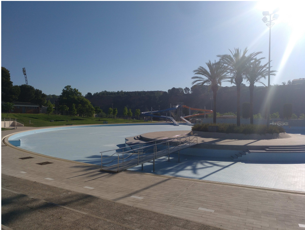
Vista general piscina buida
