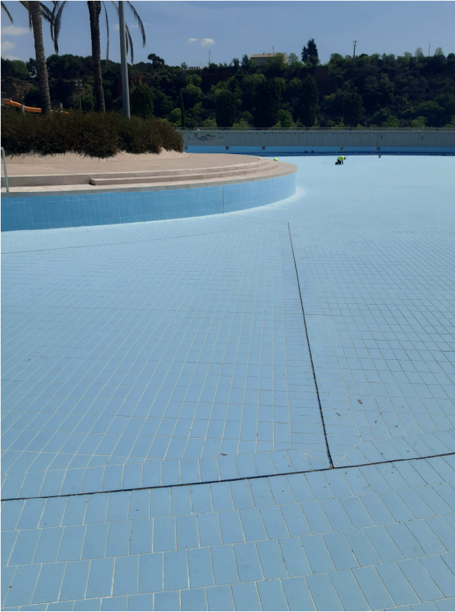
Creuament de juntes de dilatació en paviment. Peces de paviment tallades
