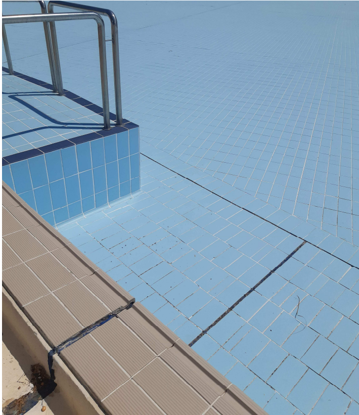
Detall de junta contínua en canal desbordant
