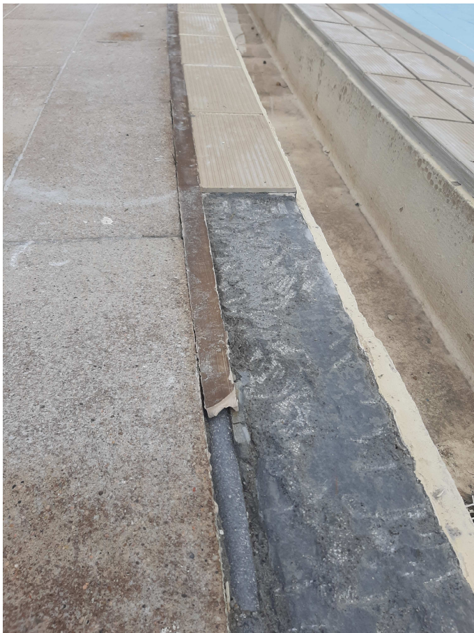
Detall de reparació peces, junta de dilatació perimetral beige i cordó de polietilè en canal perimetral desbordant
