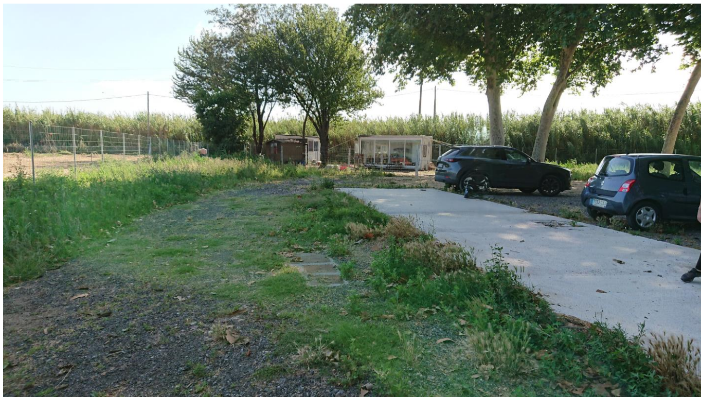
Fotografia 6. Arquetes de les instal·lacions d'electricitat, telecomunicacions i aigua potable.
