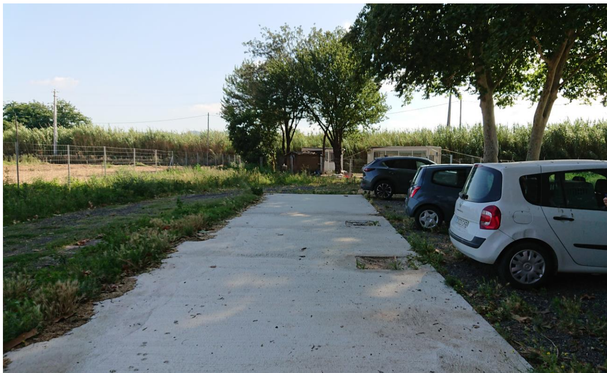
Fotografia 2. Visió direcció est de la base de formigó existent amb els espais destinats a la connexió de les instal·lacions.
