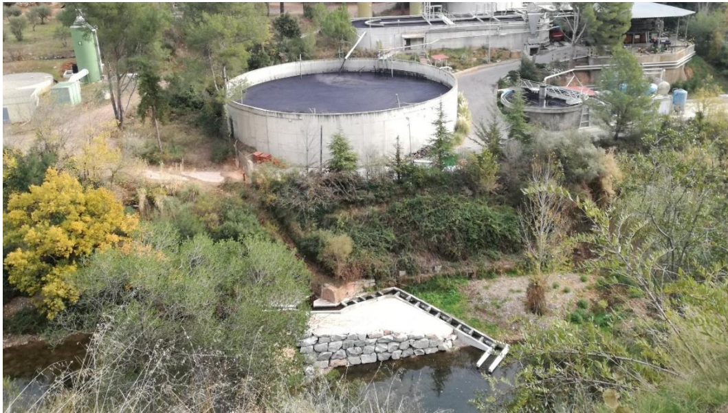
Figura 6 Situació de la depuradora de la indústria tèxtil Grau S.A a l'inici de l'àmbit del projecte (fotografia de 2017)
