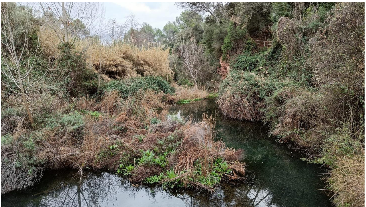
Figura 4 Vista aigües avall des de la resclosa
