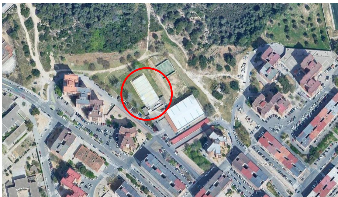
Emplaçament de la coberta a intervenir.
