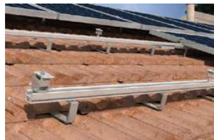
Detalle: Perfil solar-light
