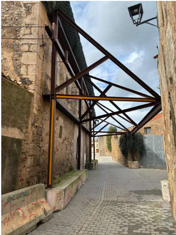
Imatge 6: Fotografia de carrer de l'estintolament de façana nord
