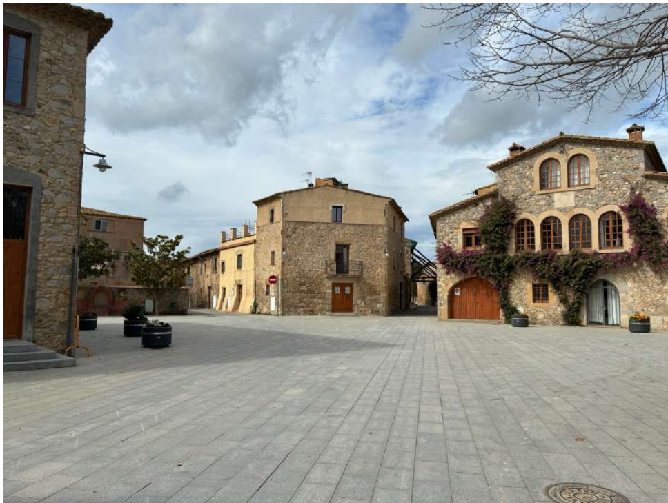
Foto 13: vista del costat de ponent de la plaça de l'Ajuntament, amb la façana de l'edifici contigu al Mas Sastre al centre de la imatge. Observar les estructures de reforç del propi mas.
