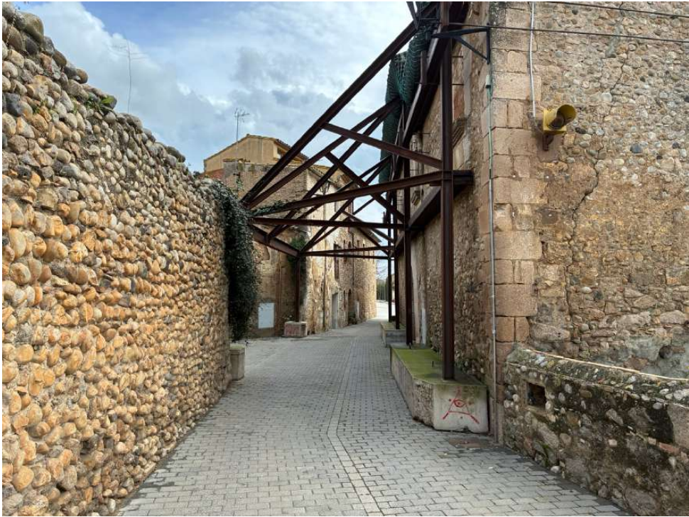
Foto 4: estructures de reforç de la façana nord.
