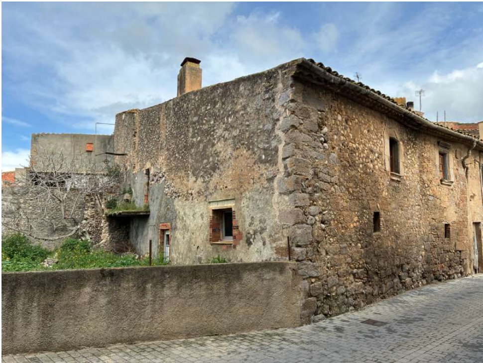
Foto 5: façana sud (masoveria).
