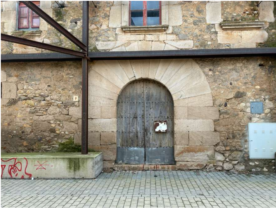
Foto 3: porta d'arc escarser de la façana nord i estructures de reforç.
