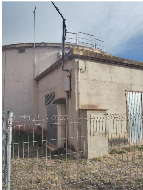
Figura 1. Vista exterior del dipòsit i la caseta.
