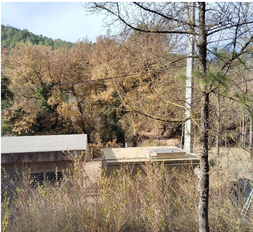
Forjats de coberta del recinte de bombament i del dipòsit annex, de formigó vist.
