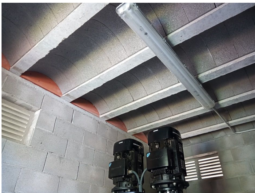
Recinte de bombament. Estructura vertical de bloc de morter i forjat unidireccional.
