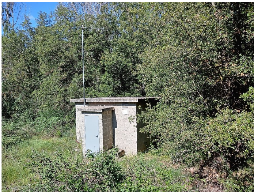
Recinte de bombament. Estructura vertical de bloc de morter i llosa massissa de coberta.
