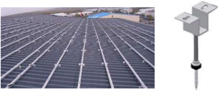
Figura 3.5 Detall de l'estructura de suport i fixacions
