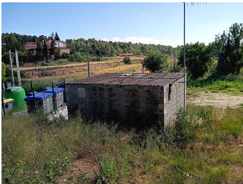
Recinte de bombament. Estructura vertical de bloc de morter i coberta de xapa ondulada sintètica.
