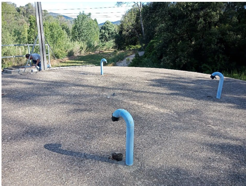
Coberta de formigó armat del dipòsit annex.
