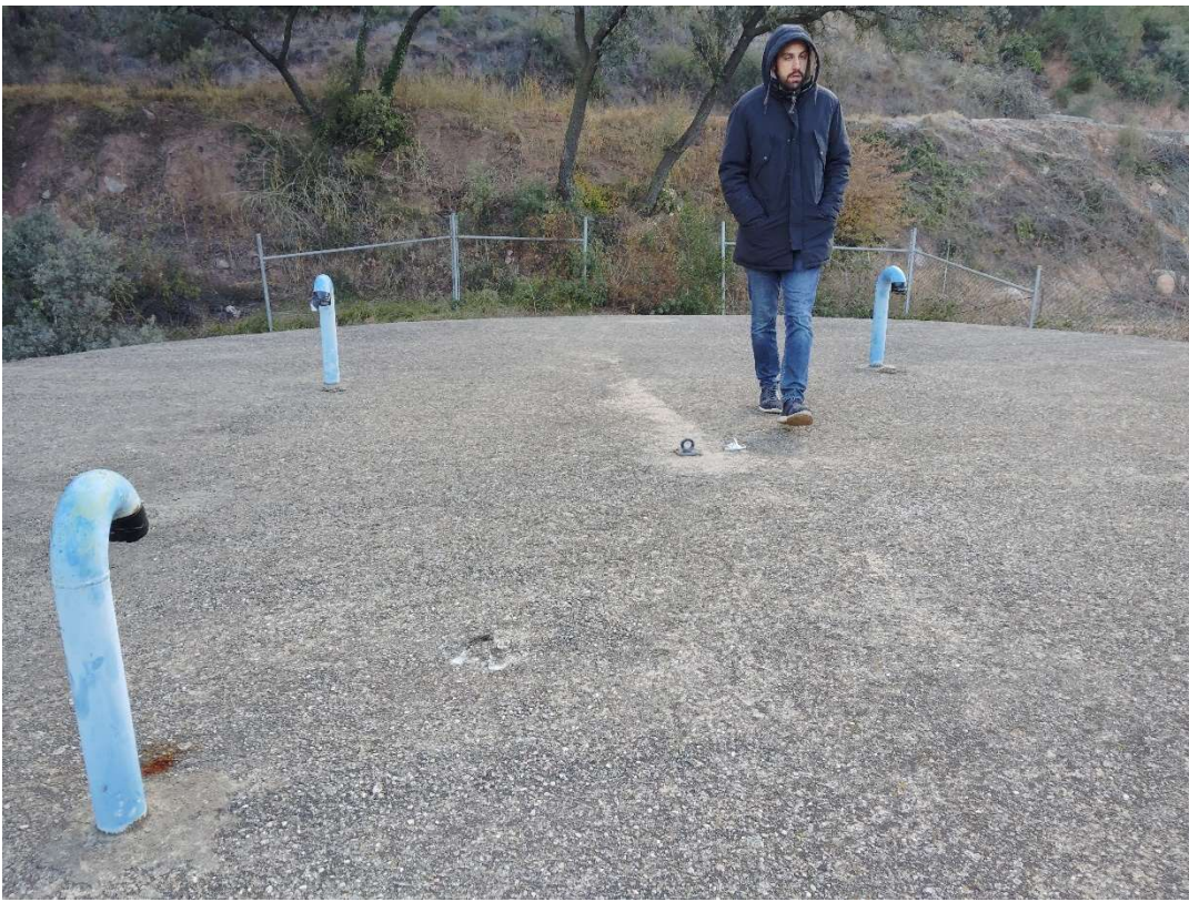
Figura 7. Coberta del Dipòsit.
