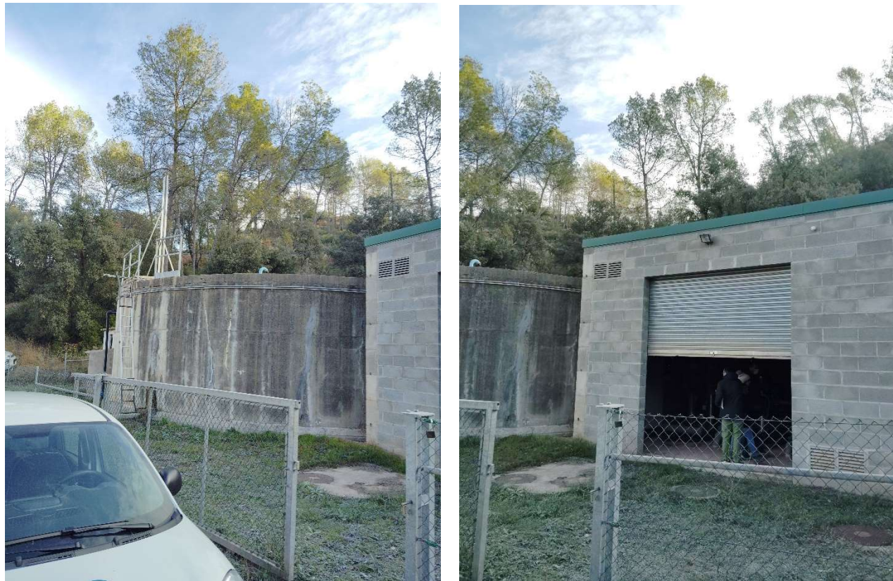
Figura 1. Vista exterior del dipòsit i la caseta.
