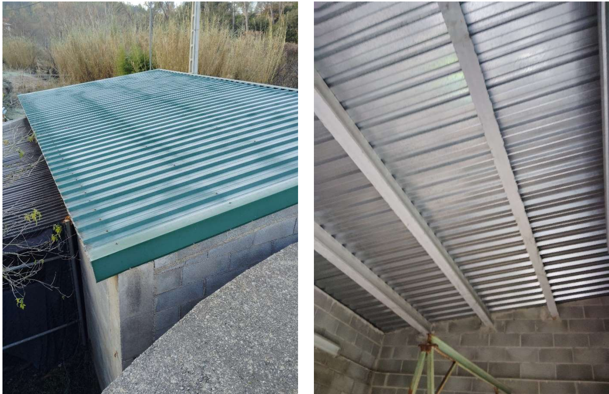
Figura 6. Coberta de la caseta i estructura que aguantala coberta.
