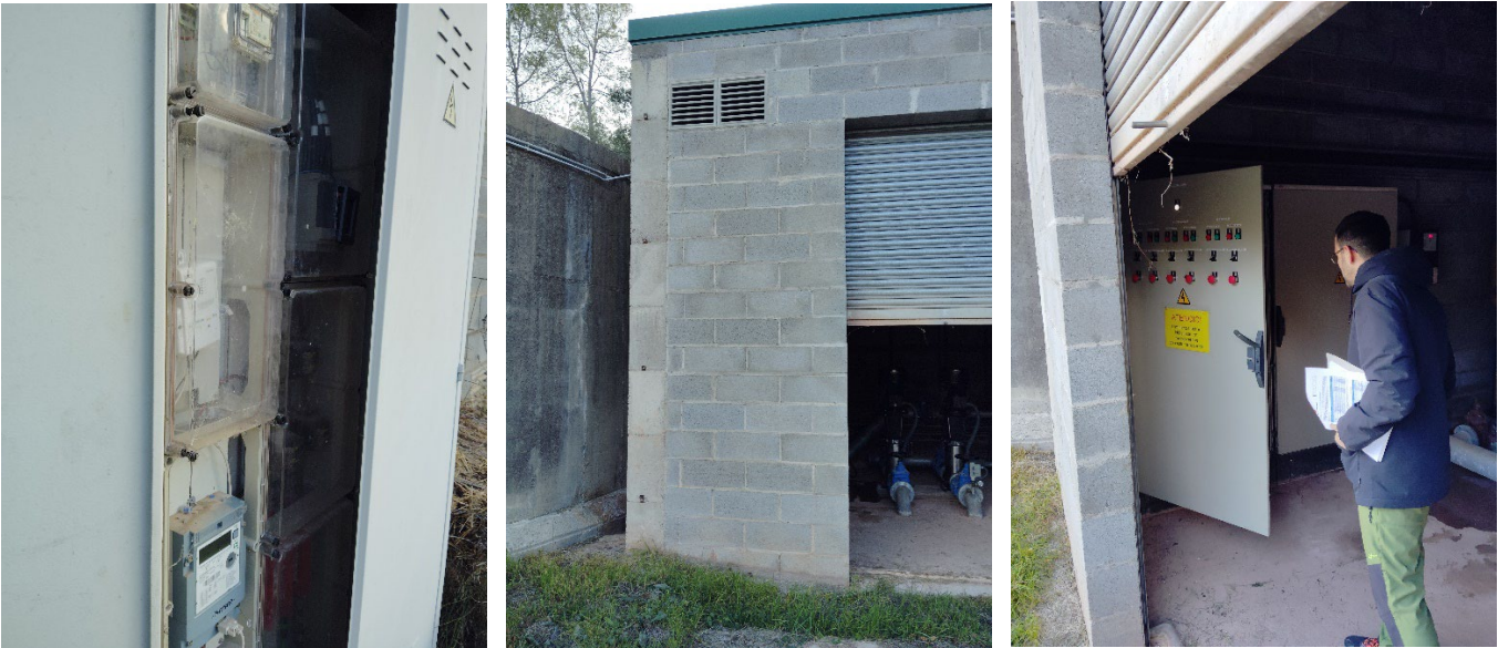
Figura 2.7. D'esquerra a dreta: TMF de consum existent, mur on anirà l'inversor i ubicació del QGBT.
