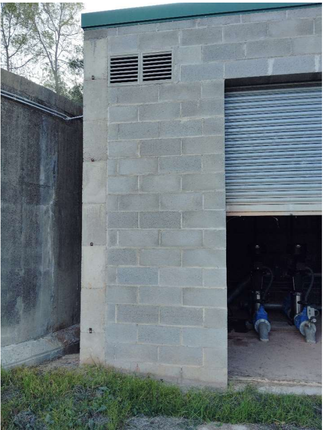
Figura 3. Mur on es col·locarà el nou armari on anirà l'inversor.
