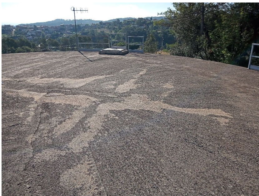
Coberta del dipòsit d'aigües. Llosa massissa.
