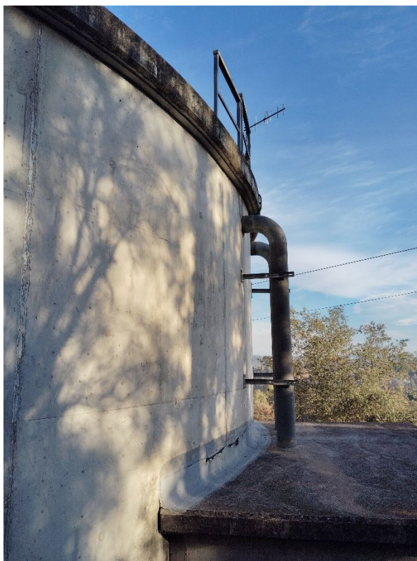
Vista lateral del dipòsit amb l'estructura vertical de formigó armat vist.
