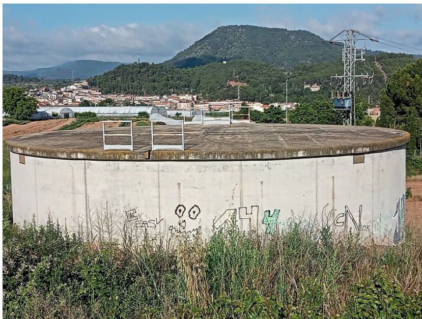
Vista lateral del dipòsit amb l'estructura vertical de formigó armat vist.
