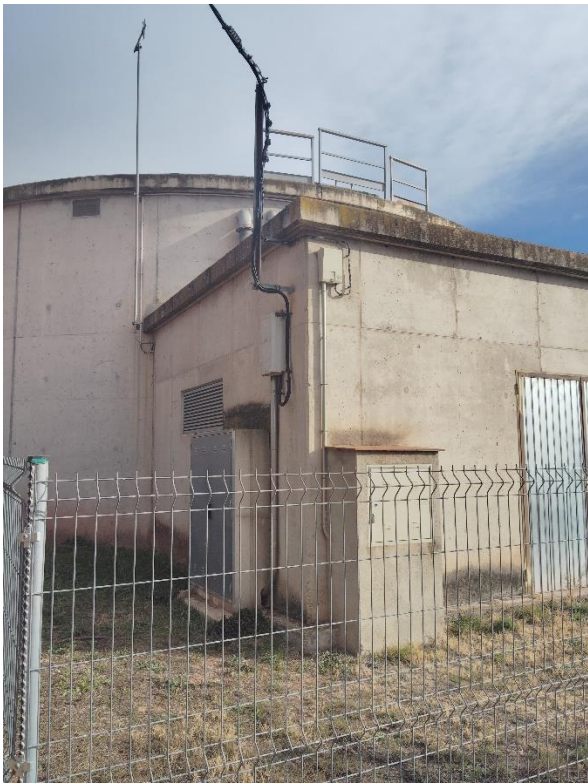
Figura 1. Vista exterior del dipòsit i la caseta.
