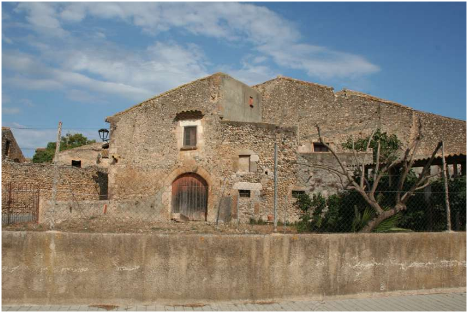
Imatge 9: Fotografia de la façana oest de Mas Sastre, amb l'espai de pati interior
