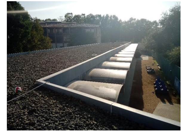
Coberta de la zona 5 on s'instal·laran els panells fotovoltaics
