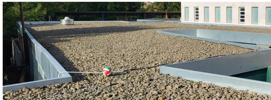
Figures 5. Coberta de la zona 1 on s'instal·laran els panells fotovoltaics.
