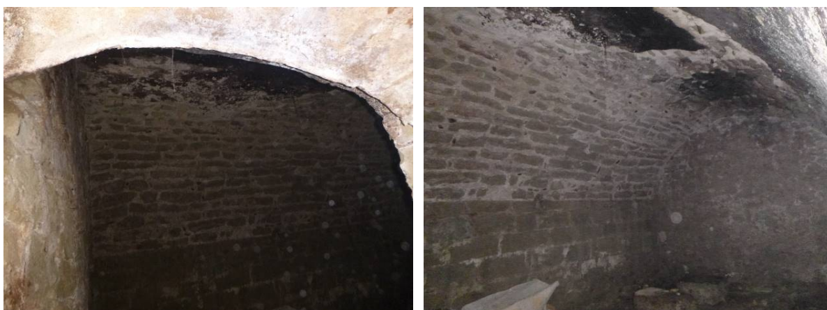
Accés al soterrani amb volta de mig punt de pedra
