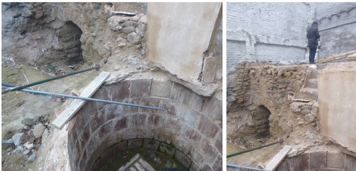
Vistes dels 3 nivells existents
