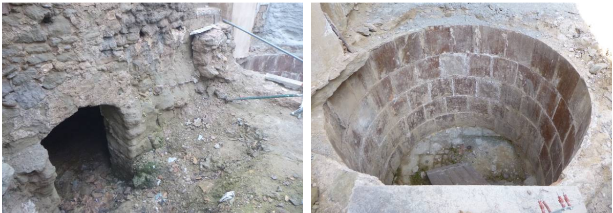
Accés al soterrani i restes d'un cub a nivell de planta baixa
