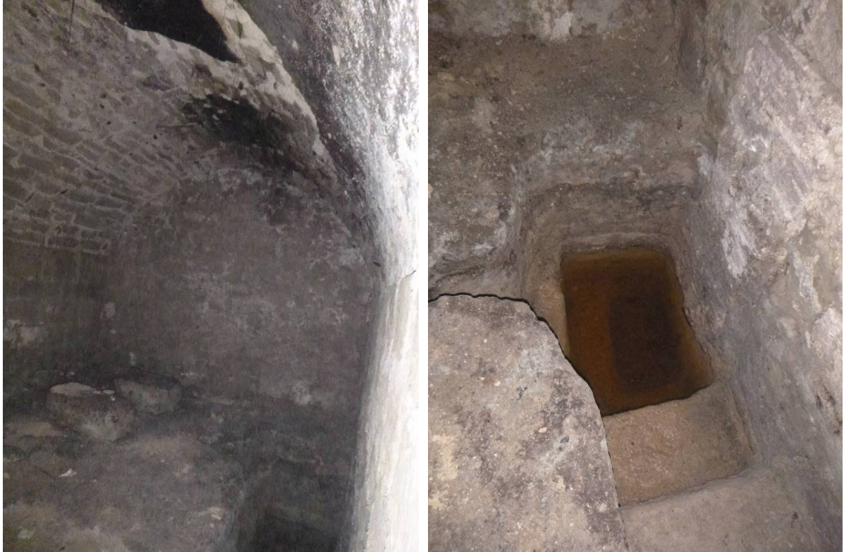
Soterrani i escales encastades en el substrat resistent rocós
