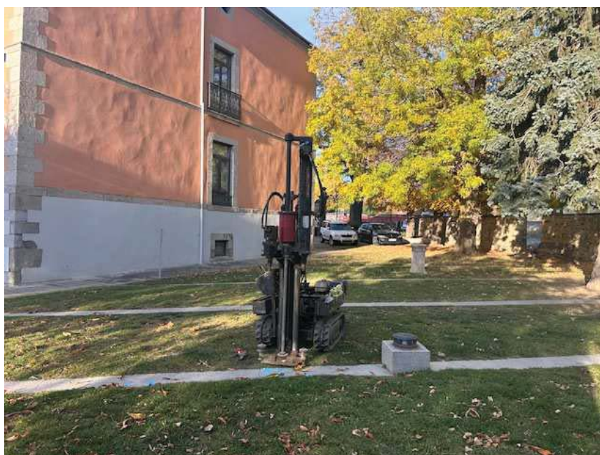
Situació i execució del penetròmetre 6.
