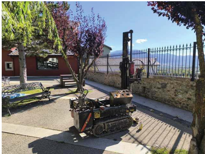
Situació i execució del penetròmetre 1.
