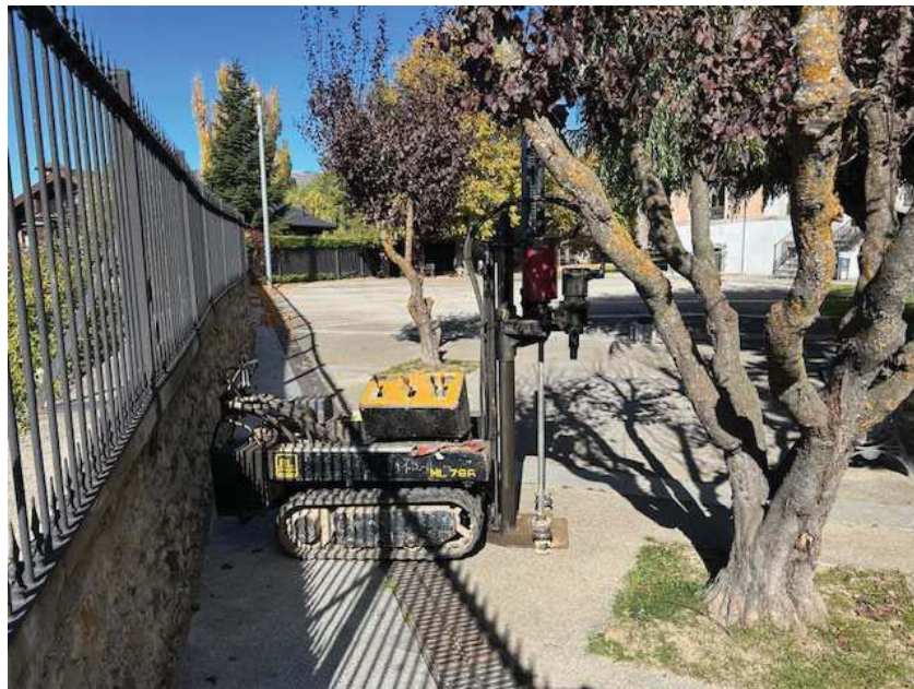
Situació i execució del penetròmetre 4.
