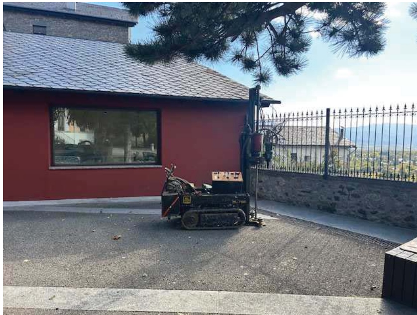
Situació i execució del penetròmetre 2.
