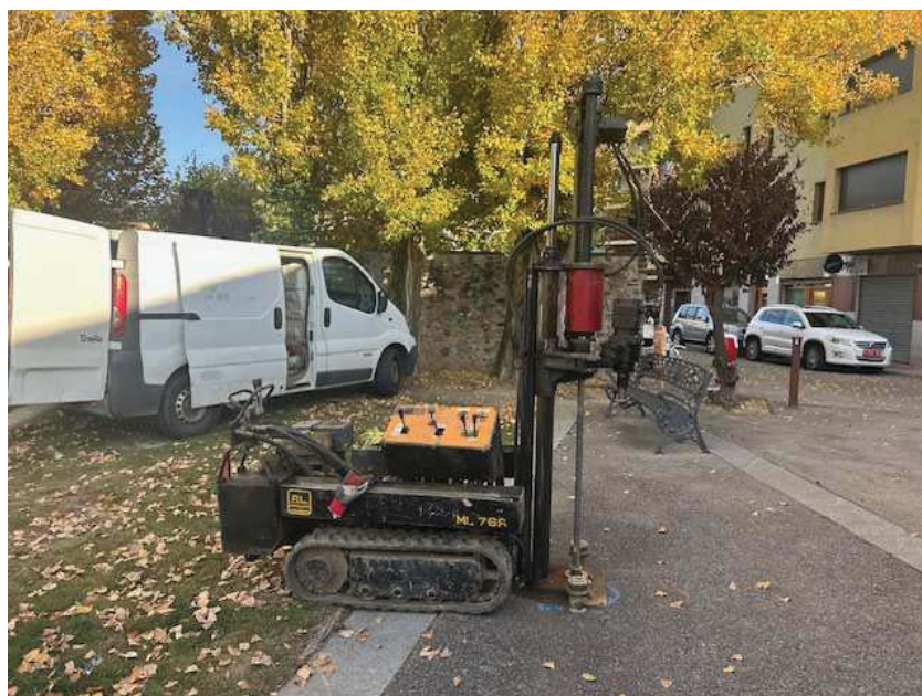
Situació i execució del penetròmetre 5.
