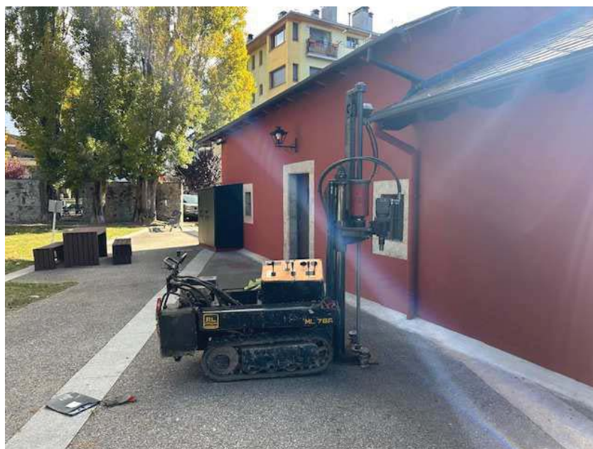
Situació i execució del penetròmetre 3.
