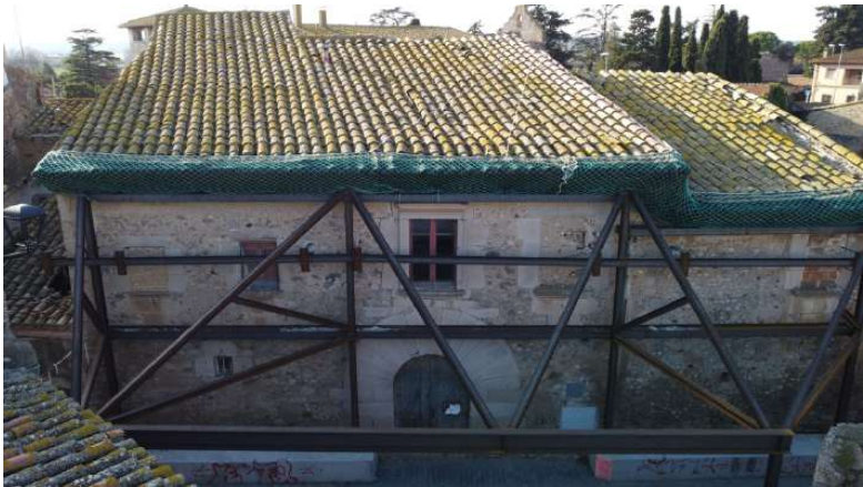
Imatge 5: Fotografia aèria de l'estintolament de façana nord
