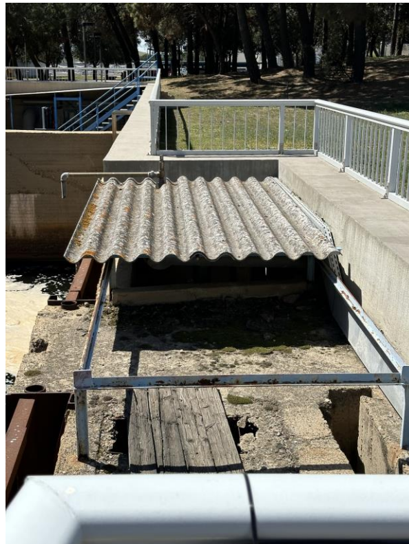
Imatge de la coberta de fibrociment
