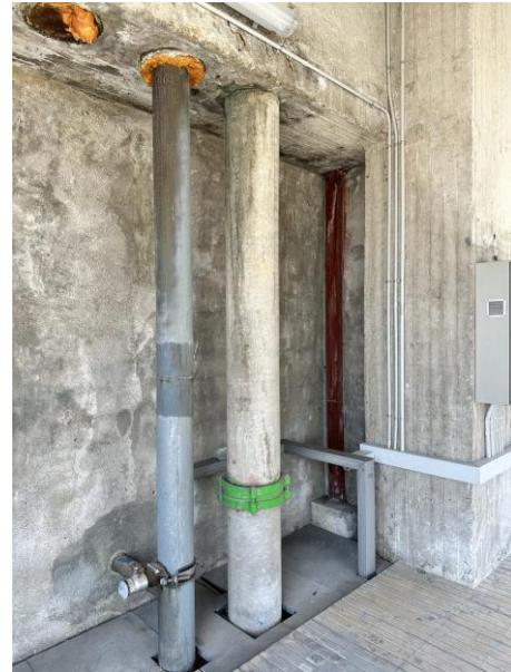
Imatge detall dels trams dels tubs de fibrociment
