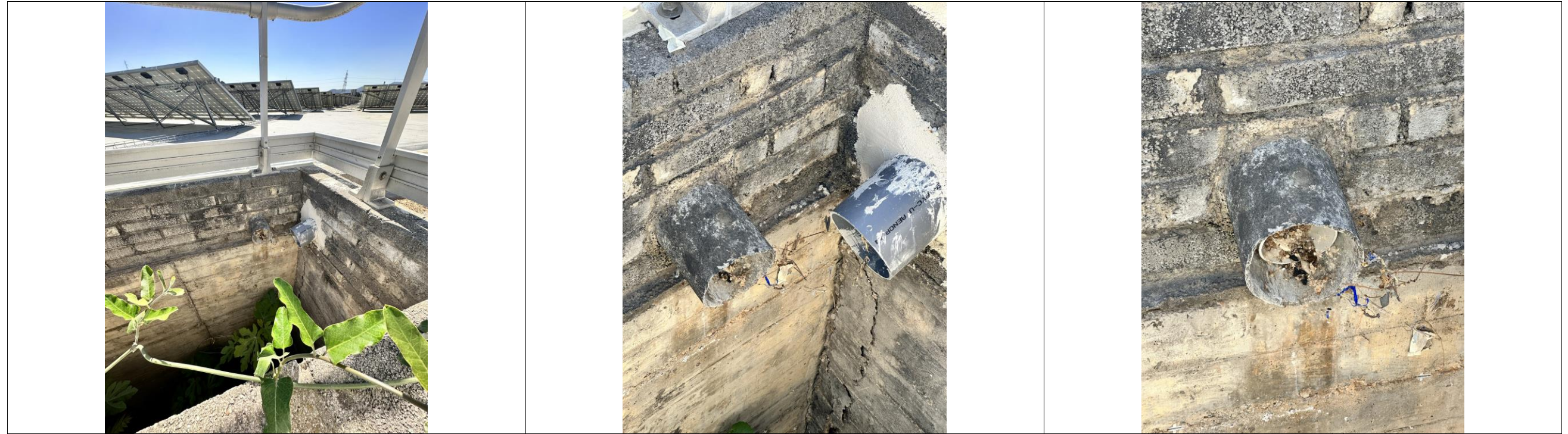
AB-10 Tub baixant de fibrociment
