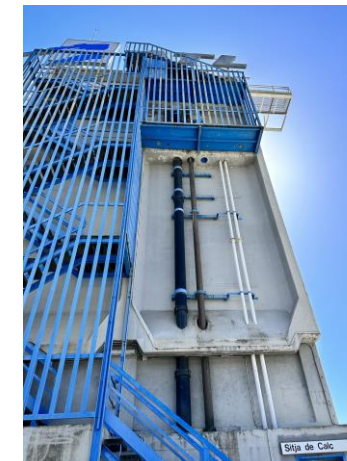
Imatge general de la façana de l'edifici de Sitges de carbó.
