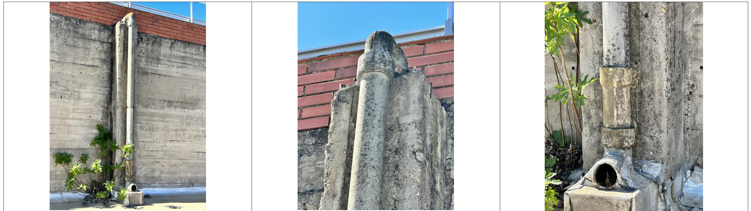
AB-10 Tub baixant de fibrociment
