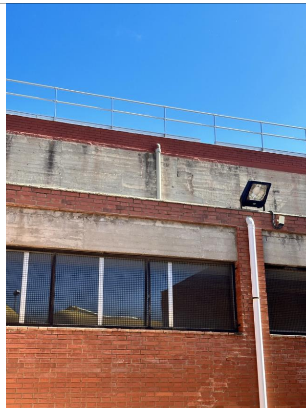
AB-04 Tub baixant de fibrociment
