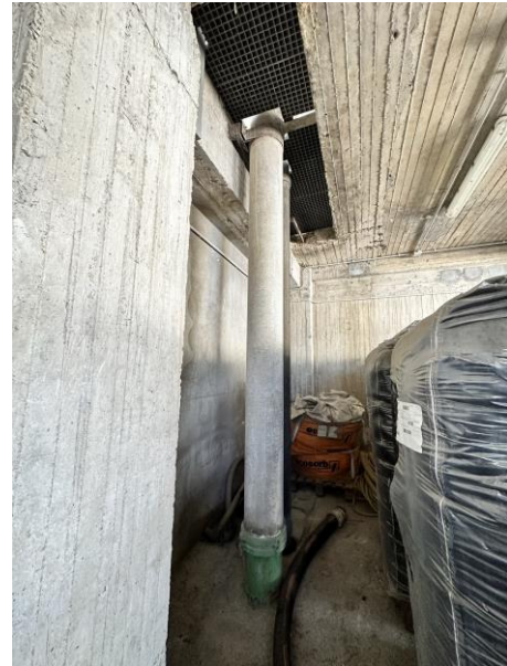
Imatge detall dels trams dels tubs de fibrociment
