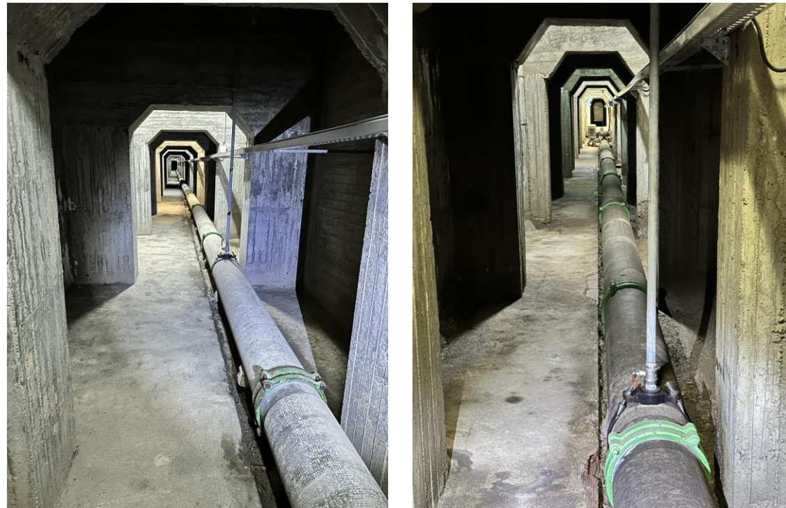
Imatges dels trams de tubs a la zona de decantadors
