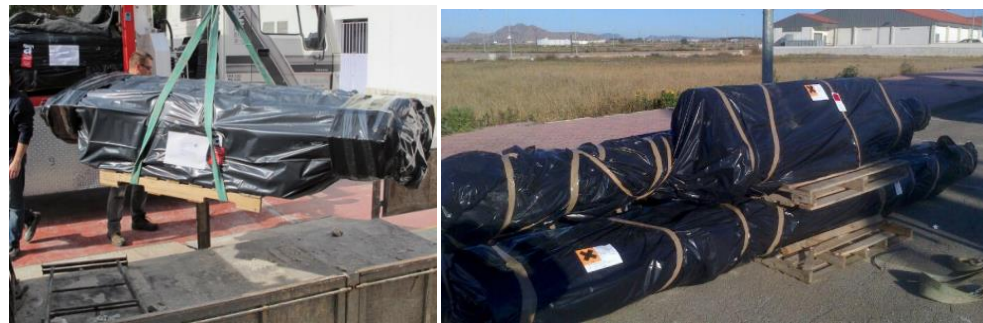
Exemple d'emmagatzematge temporal de tubs de fibrociment
