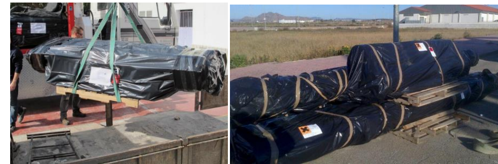
Exemple d'emmagatzematge temporal de tubs de fibrociment
