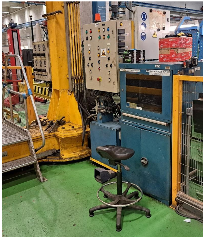
Fig. 5. Vista de la unitat hidràulica i del lloc d'operador.
