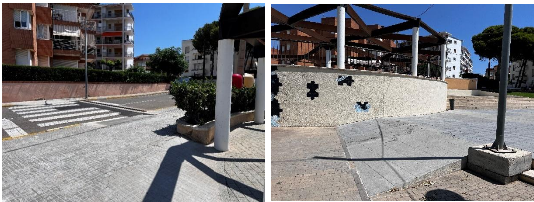
Imágenes: Accesos Mirador Plaza del Coll de Balaguer. Fuente: Fotografías tomadas durante la visita.
