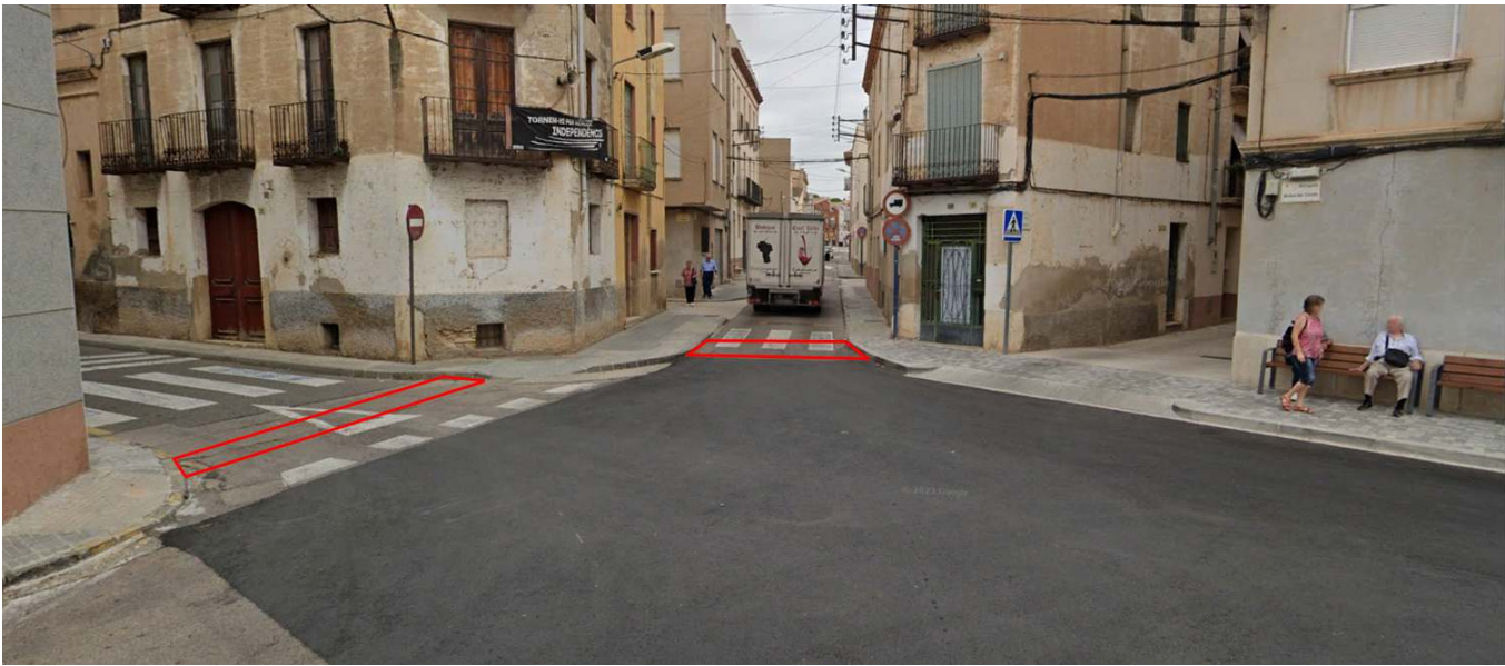
Vista general ubicació interceptors núm. 3 i núm. 4
