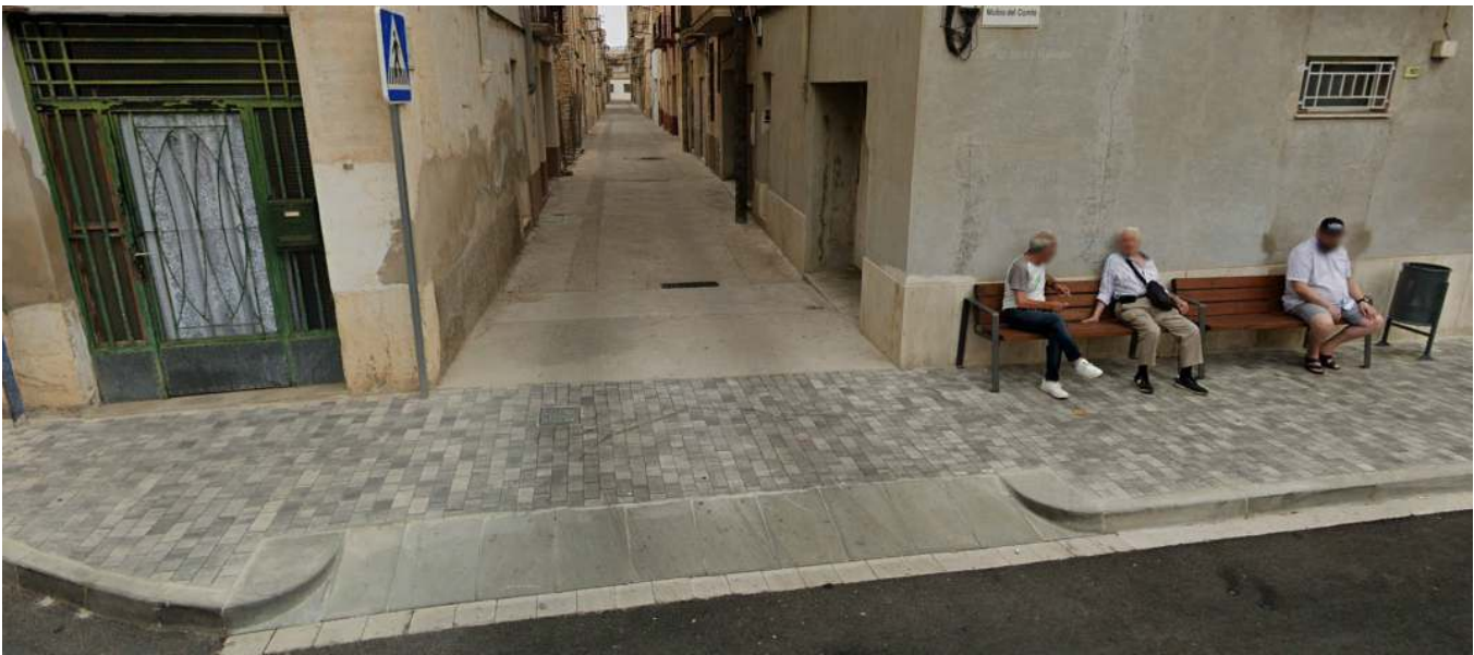
Vista general c/ Fortuna des de l'Av. Molins d'en Comte
