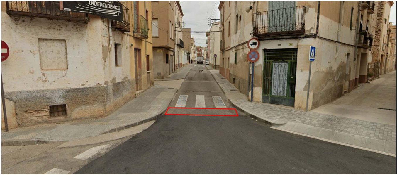
C/ de la sèquia. Interceptor núm. 3
