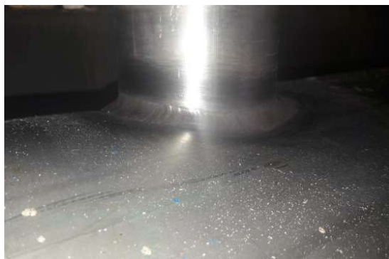
Figura 2. Diverses reparacions efectuades i reforços soldats al col·lector
