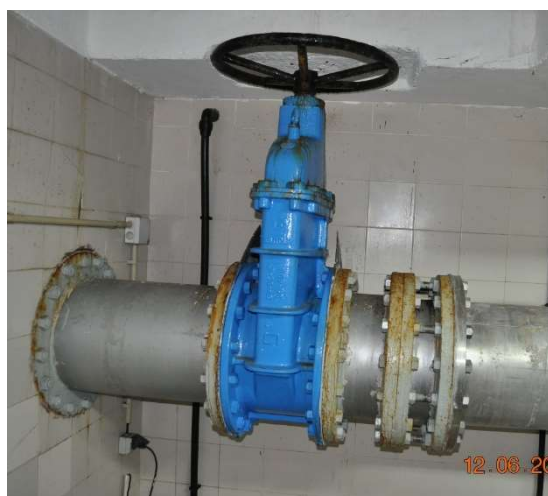
Figura 1. Imatges generals i de detall del col·lector d'impulsió existent
